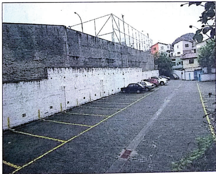
ENTRADA DE GARAGEM, COM ACESSO PELA RUA DANIELI CRESPI.
