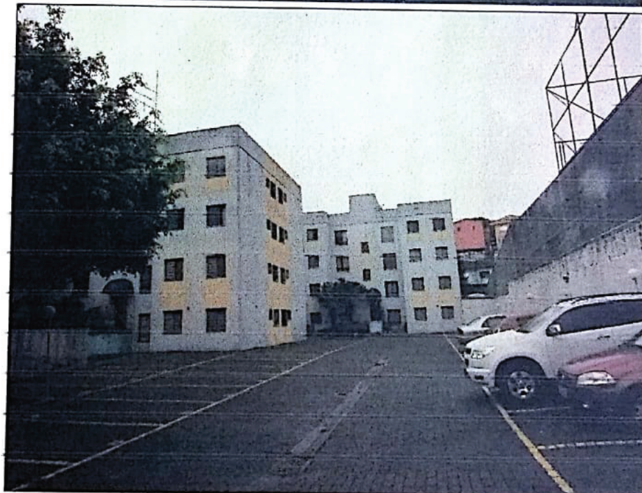
VAGAS DE ESTACIONAMENTO, NO PAVIMENTO TÉRREO.
