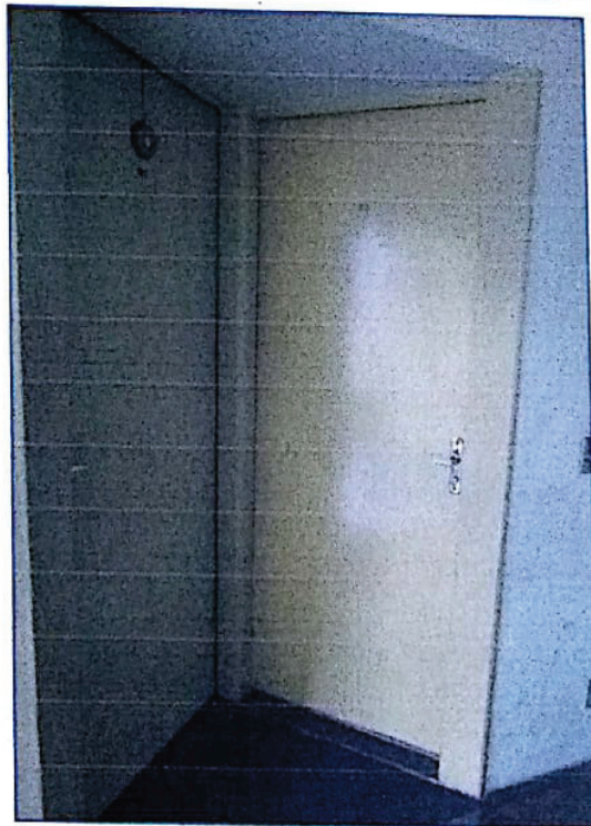
HALL DO PAVIMENTO TÉRREO - BLOCO 02.
