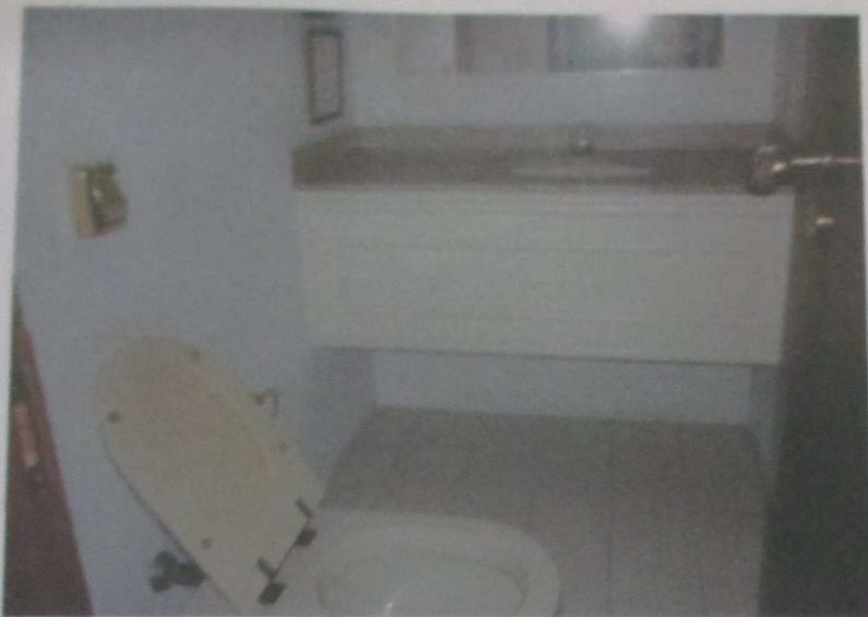
FOTO 04: - Vista do lavabo do imóvel.
