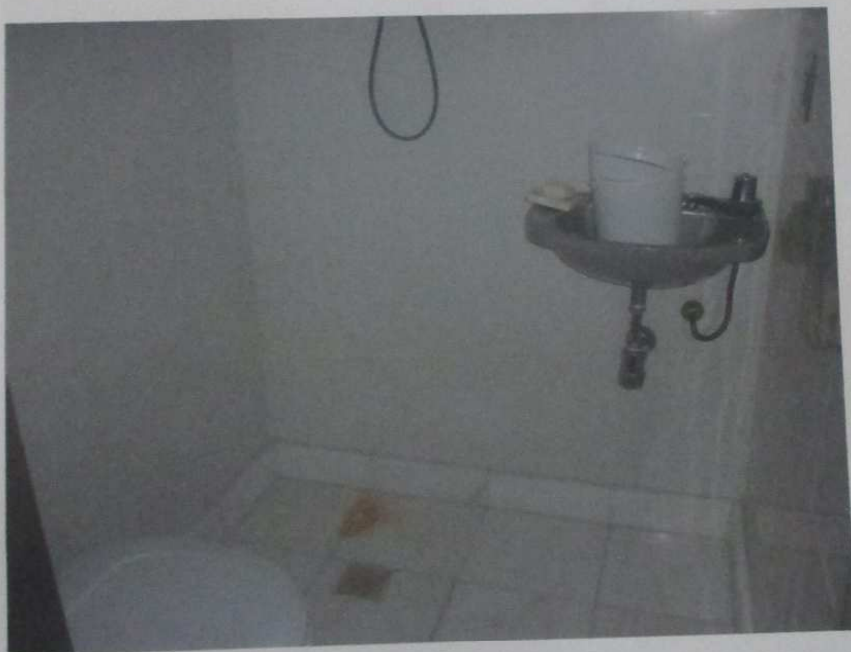
FOTO 15:- Vista do banheiro de empregada do imóvel.
