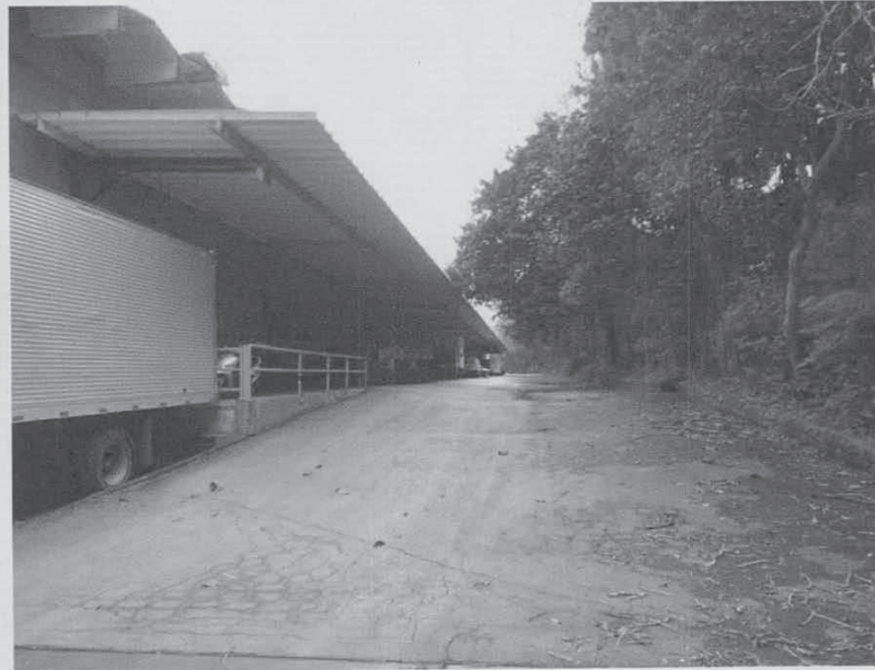
VISTA DA DOCA DE CARREGAMENTO/DESCARREGAMENTO DE MERCADORIAS.
