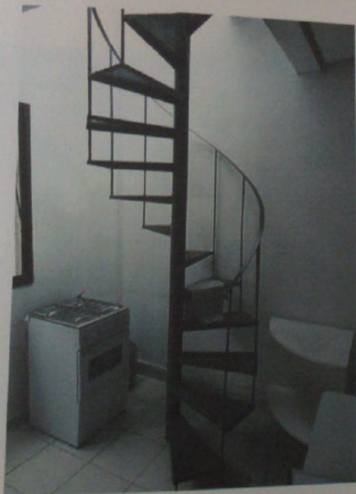
VISTA DA ESCADA DE ACESSO AO TERRAÇO.
