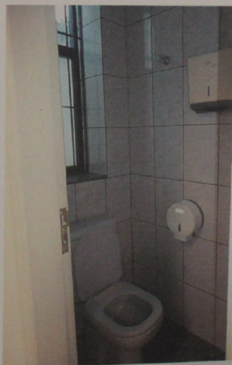
VISTA DO BANHEIRO.
