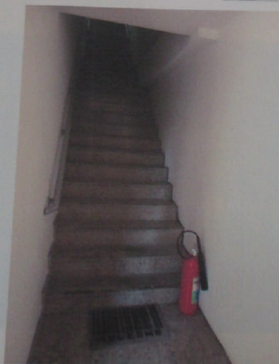
VISTA DA ESCADA DE ACESSO AO SUBSOLO.
