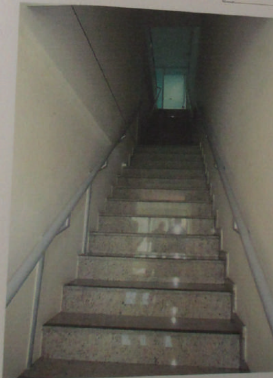
VISTA DA ÁREA ADMINISTRATIVA DO PRIMEIRO PAVIMENTO.
