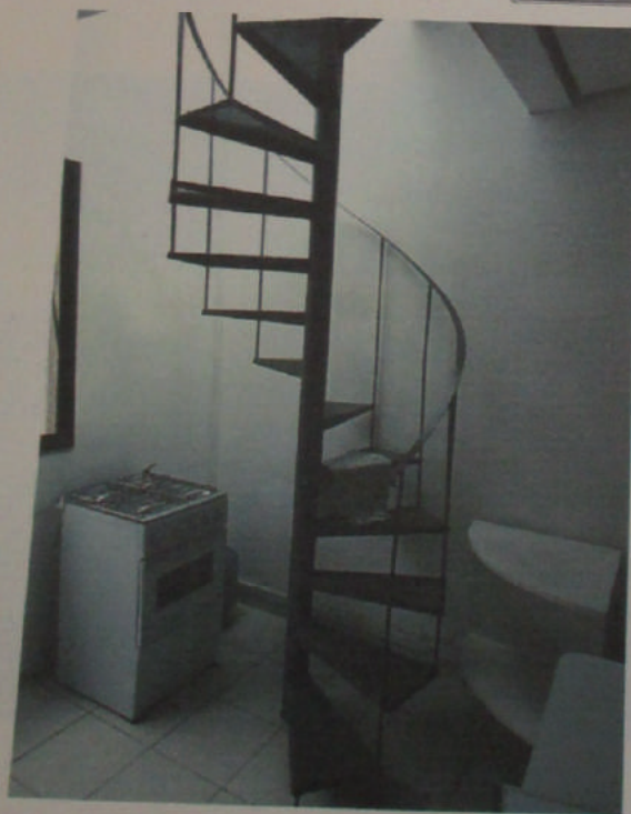
VISTA DA ESCADA DE ACESSO AO TERRAÇO.
