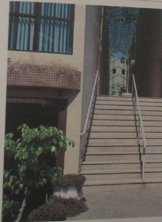
VISTA DA ÁREA DE CIRCULAÇÃO EXTERNA.
