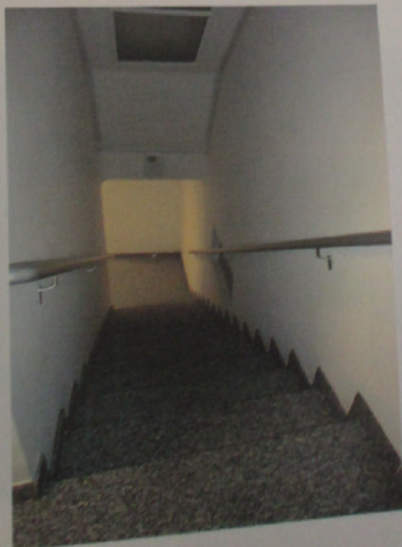
VISTA DA ESCADA DE ACESSO AO PISO INFERIOR.
