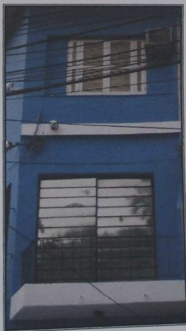
Foto 3 – Fachada frontal – Detalhe dos caixilhos do pavimento térreo e superior.
