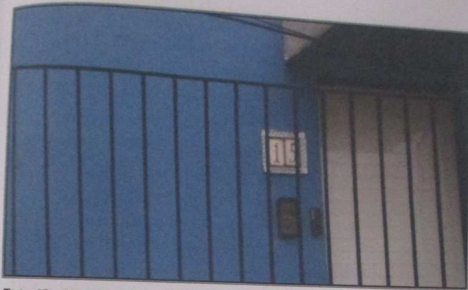
Foto 12 – Identificação do número do imóvel junto a porta de acesso lateral (Rua Salto Grande).
