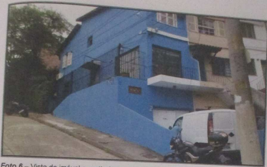
Foto 6 – Vista do imóvel a partir da esquina da Rua Salto Grande.
