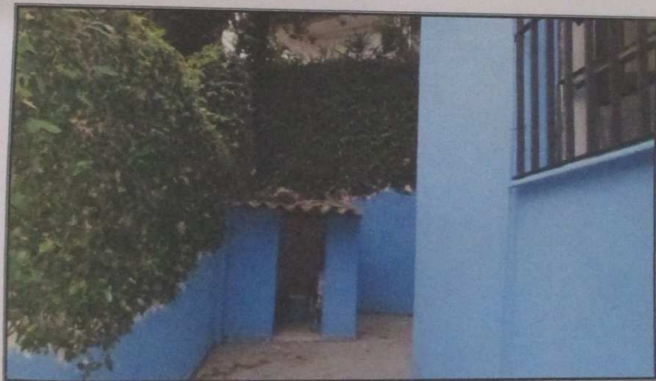
Foto 11 – Vista dos fundos do terreno.
