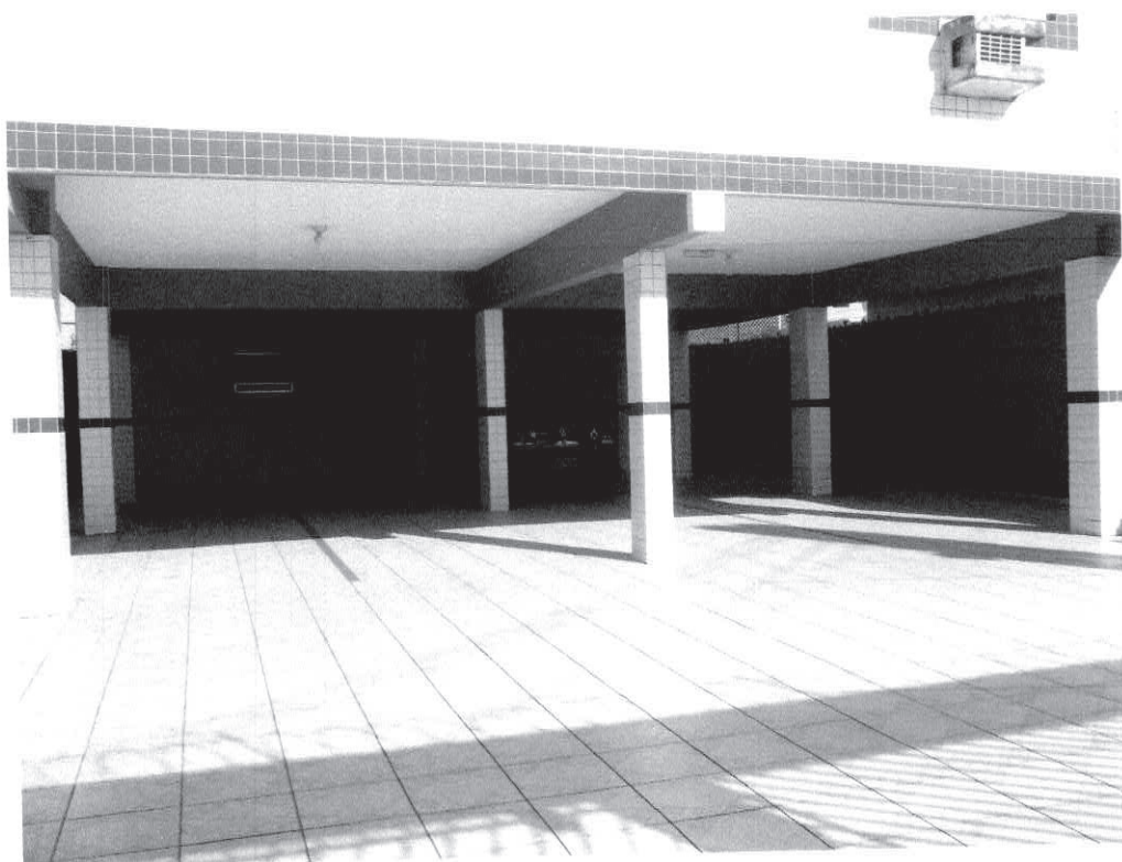
Foto nº 03: Vista geral do pavimento térreo.
