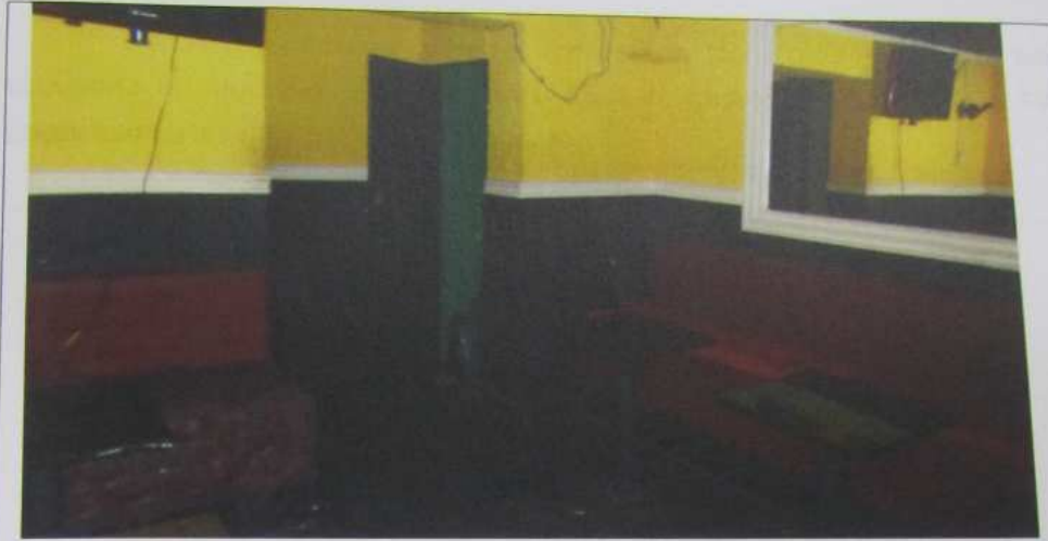
FOTO N° 14 – VISTA DA SALA DE ESTAR.
