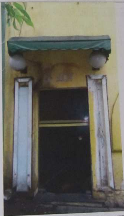
FOTO Nº 08 – VISTA EXTERNA DA ENTRADA DO IMÓVEL AVALIANDO.
