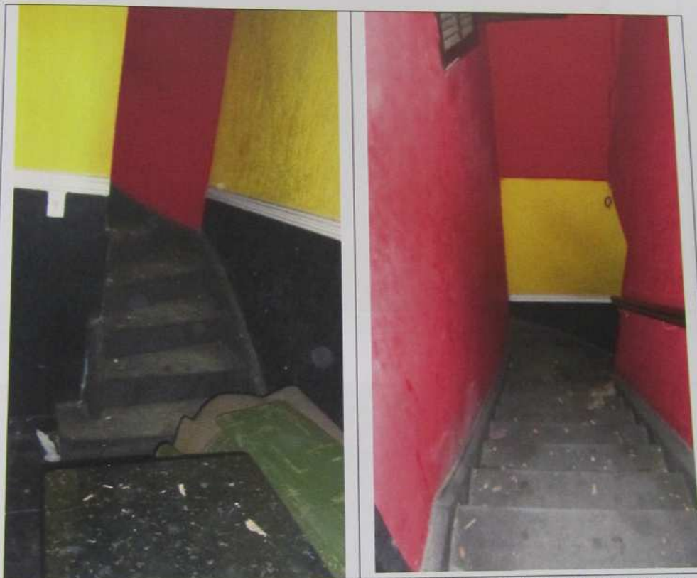
FOTOS Nº 20 - 21 - VISITAS DA ESCADA DE ACESSO AO PAV. SUPERIOR.
