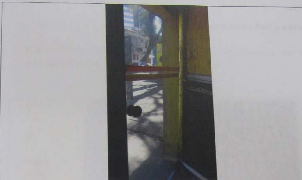
FOTO Nº 09 – VISTA INTERNA DA ENTRADA DO IMÓVEL.
