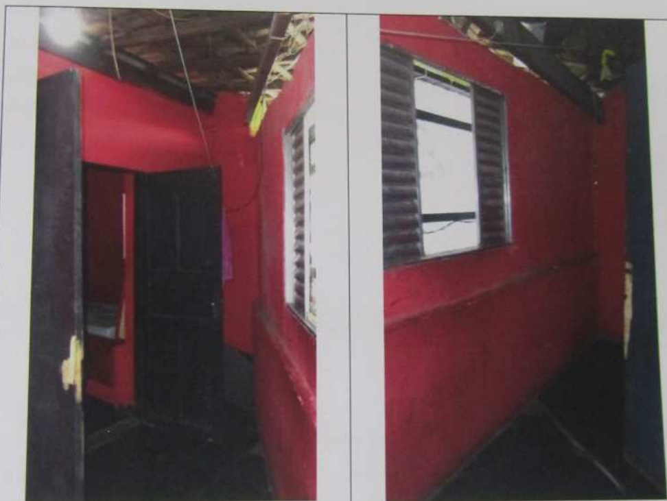
FOTOS Nº 33 - 34 - VISTA DA ÁREA DE SERVIÇO
