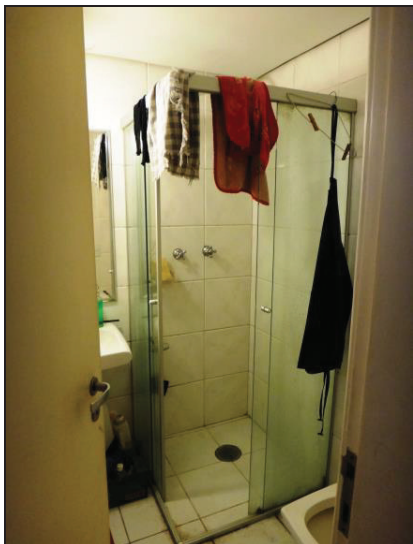
Vista do banheiro 1
