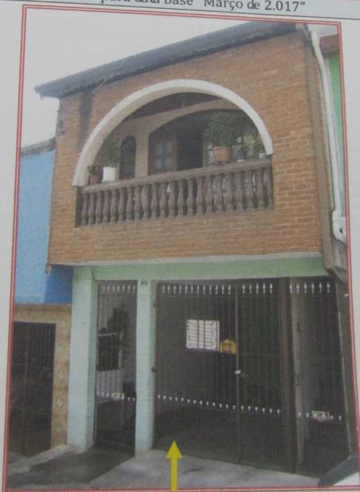
Foto: Vista geral da fachada do imóvel, objeto da avaliação.
