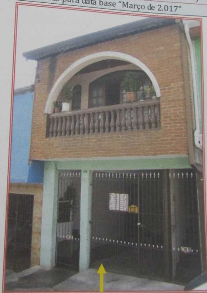
Foto: Vista geral da fachada do imóvel, objeto da avaliação.
