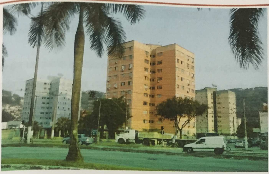
Vistas da fachada do edifício Perequê.
