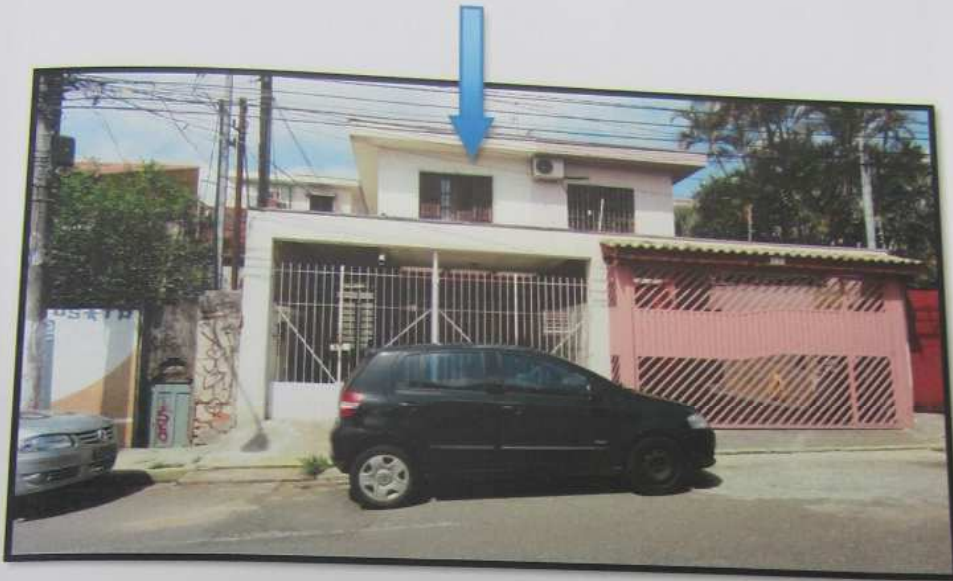
Foto 1. Vista Imóvel Avaliando.
