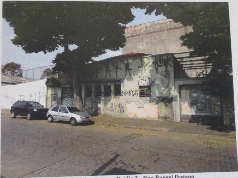
Figura 9 – Vista externa Prédio 2 - Rua Rangel Pestana
