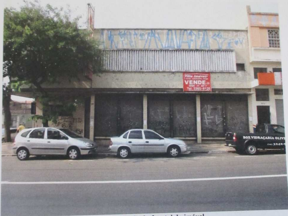
Figura 5– Fachada frontal do imóvel.
