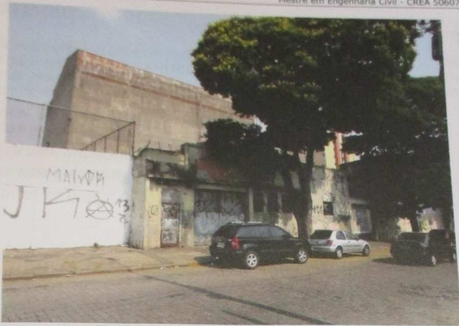
Figura 8 – Vista externa Prédio 2 - Rua Rangel Pestana.
