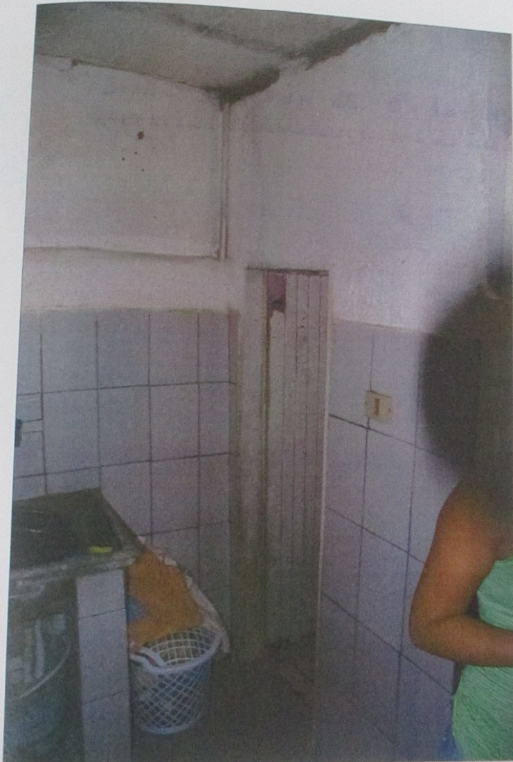
A área de serviço.
