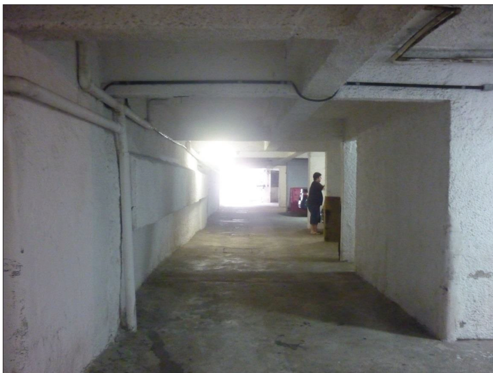
FOTO 16:- Outra vista do subsolo do Edifício Res Verde Mar.
