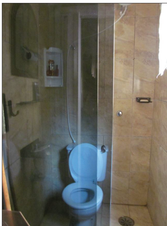
FOTO 07:- Vista interna do banheiro de empregada de um imóvel similar (nº15).
