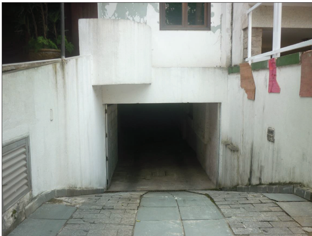
FOTO 15:- Vista da entrada do subsolo do Edifício Res Verde Mar.
