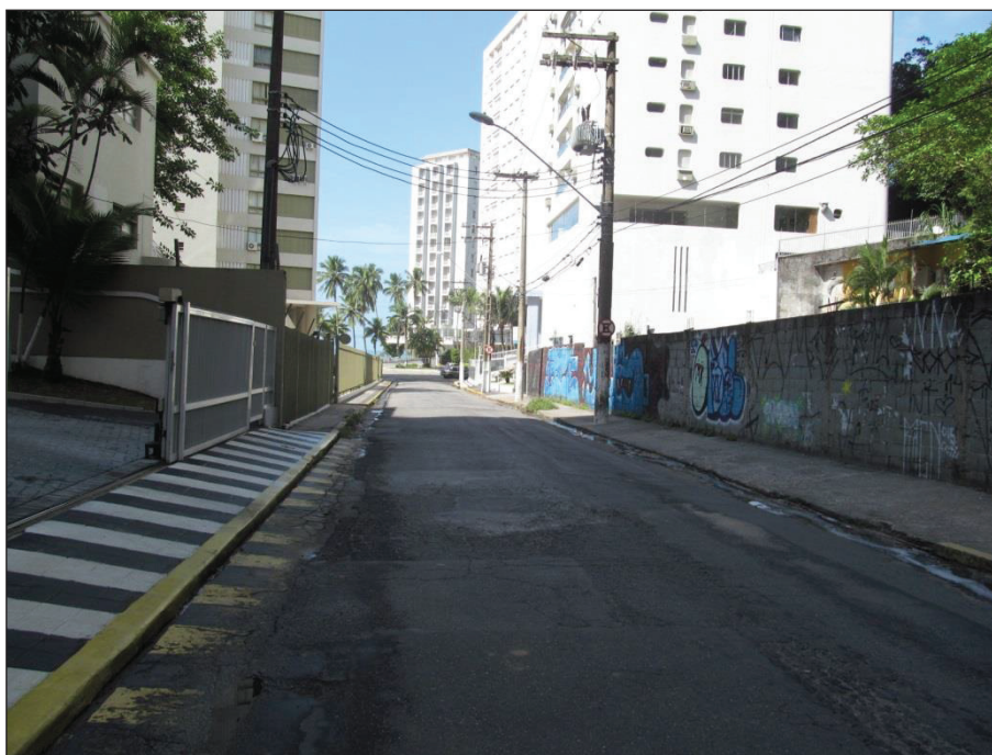
FOTO 01 :- Vista do logradouro do imóvel.
