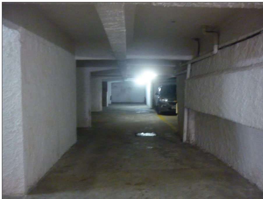
FOTO 14:- Vista do subsolo do Edifício Res Verde Mar.
