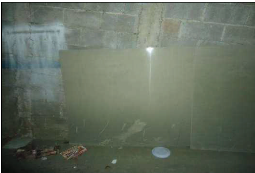
ITEM 5,004 - VISTA DA CHAPA DE POLIPROPILENO DIM:2,30X1,30X12MM (COMPRIMENTO X LARGURA X ESPESSURA)
