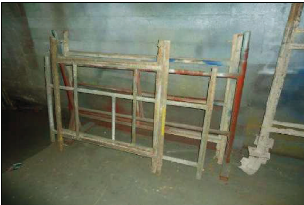
ITEM 5,007 - VISTA DOS ELEMENTOS DE COMPOSIÇÃO DE ANDAIME
