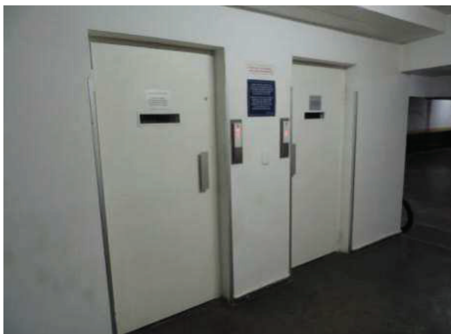
Foto nº. 11 – Vista dos elevadores localizados no subsolo.
