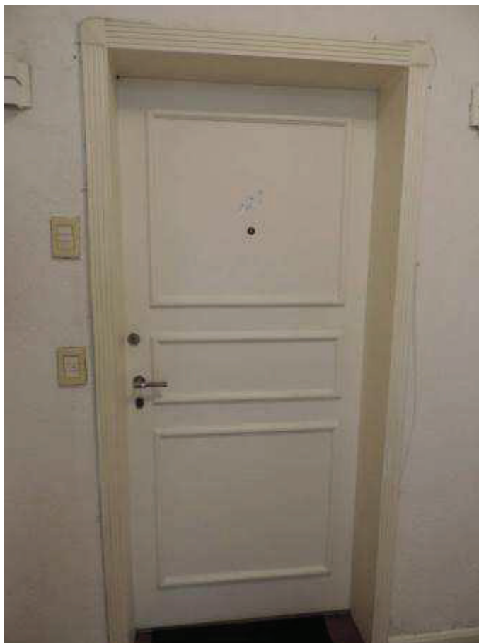
Foto nº. 12 – Vista da entrada do apartamento nº 121, avaliado no presente laudo.
