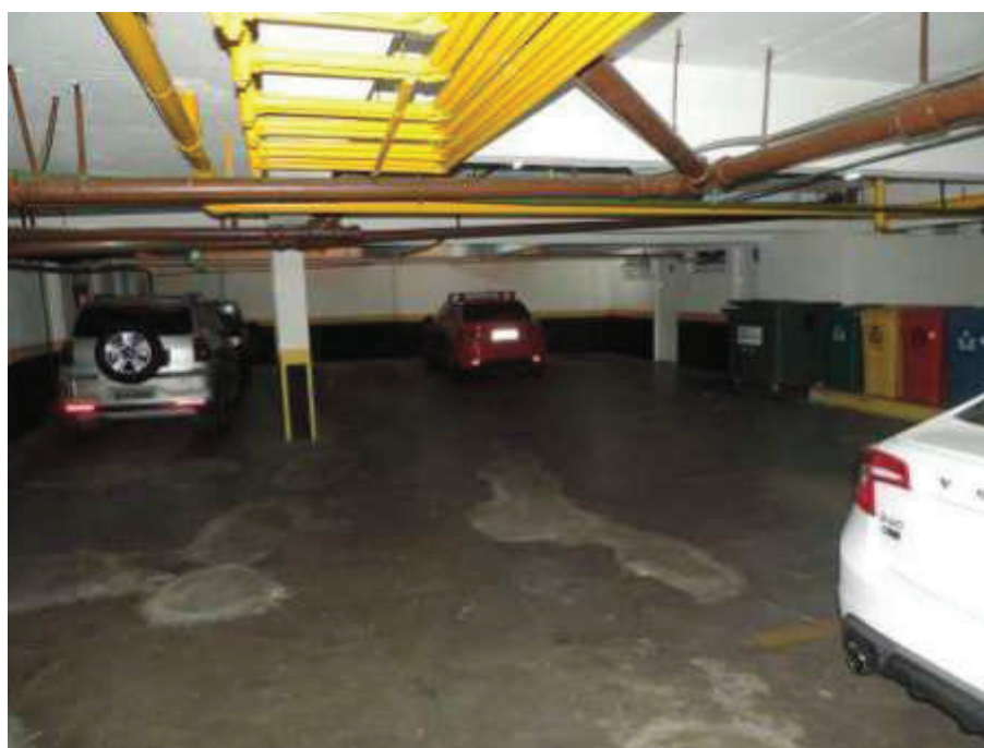
Foto nº. 7 – Vista parcial do primeiro subsolo.
