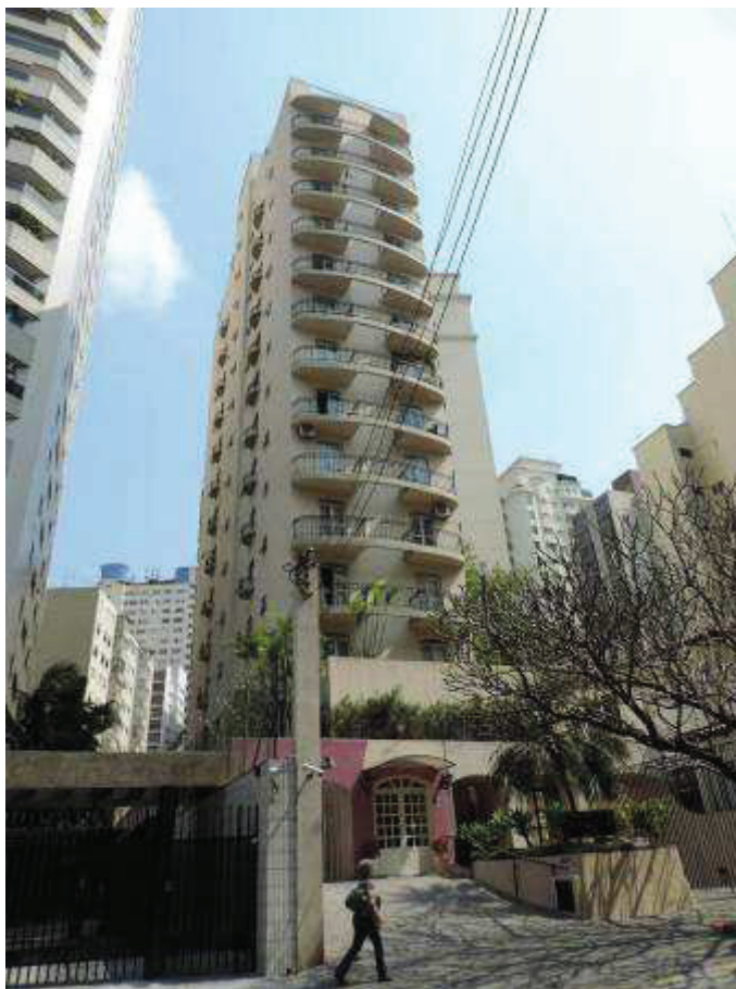
Foto nº. 3 – Vista da fachada do Edifício Flat Service Higienópolis, onde se localiza o imóvel avaliado no presente laudo.
