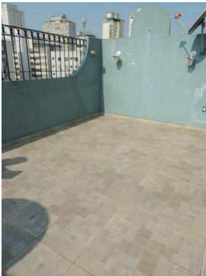
Foto nº. 29 – Vista do terraço descoberto.
