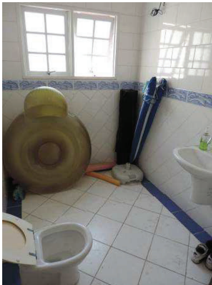
Foto nº. 6 – Vista de um dos sanitários junto a área destinada a lazer, localizada no pavimento térreo do imóvel.
