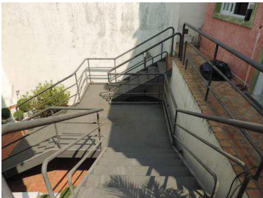
Foto nº. 10 – Vista da escada metálica de acesso ao pavimento inferior do imóvel.
