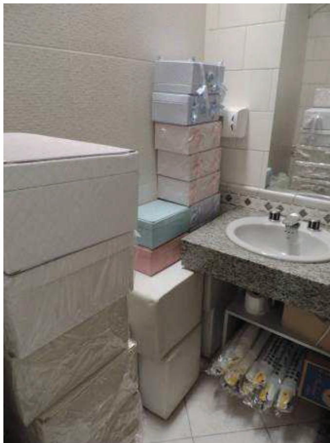
Foto nº. 9 – Vista parcial do banheiro junto a sala destinada a escritório e reuniões, localizada no pavimento térreo do imóvel.
