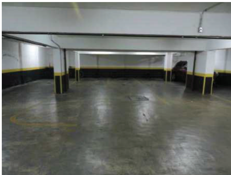
Foto nº. 10 – Outra vista parcial do segundo subsolo.
