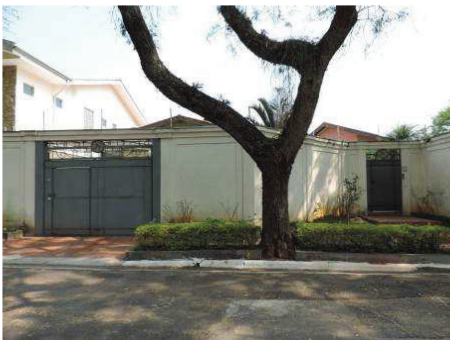
Foto nº. 2 – Vista da fachada do imóvel avaliando.
