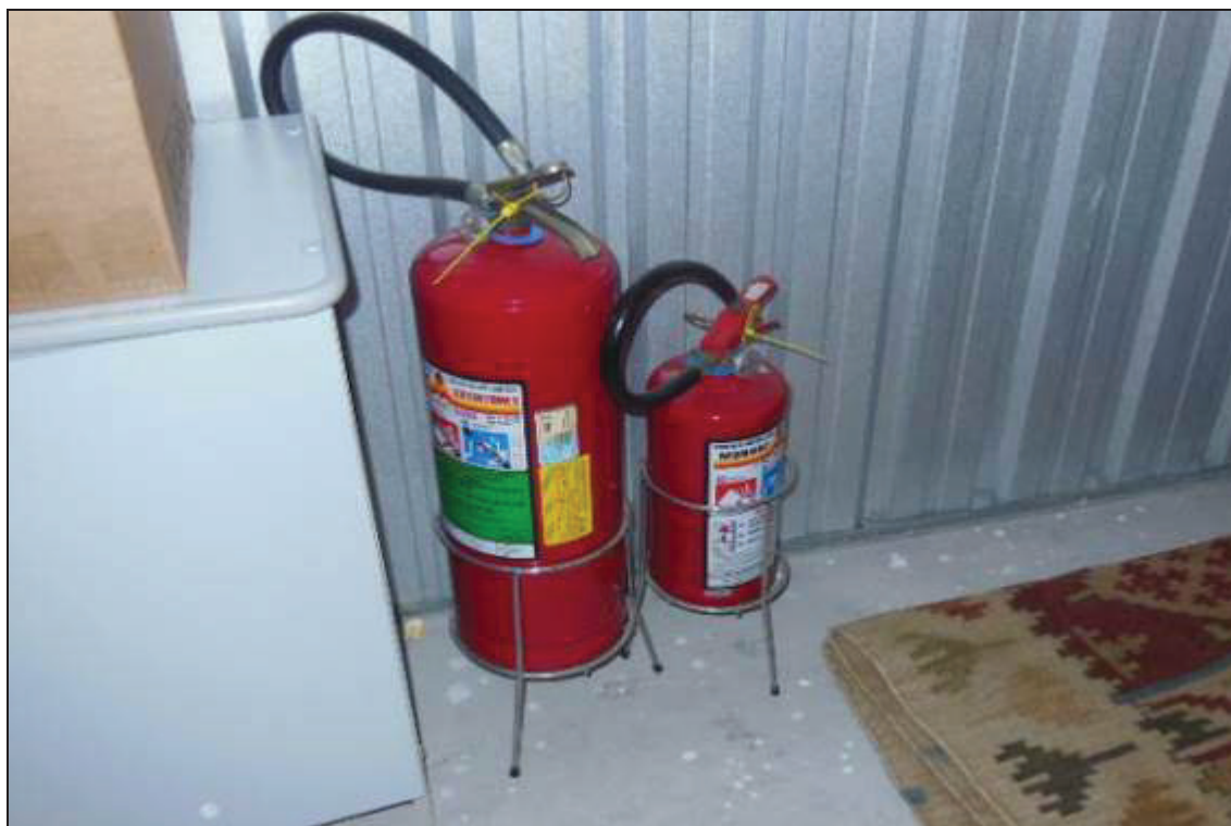
ITEM 1,017 / ITEM 1,018 – VISTA DO EXTINTOR AGUA PRESSURIZADA CAP: 10L E DO EXTINTOR DE PÓ QUÍMICO CAP: 04 KG
