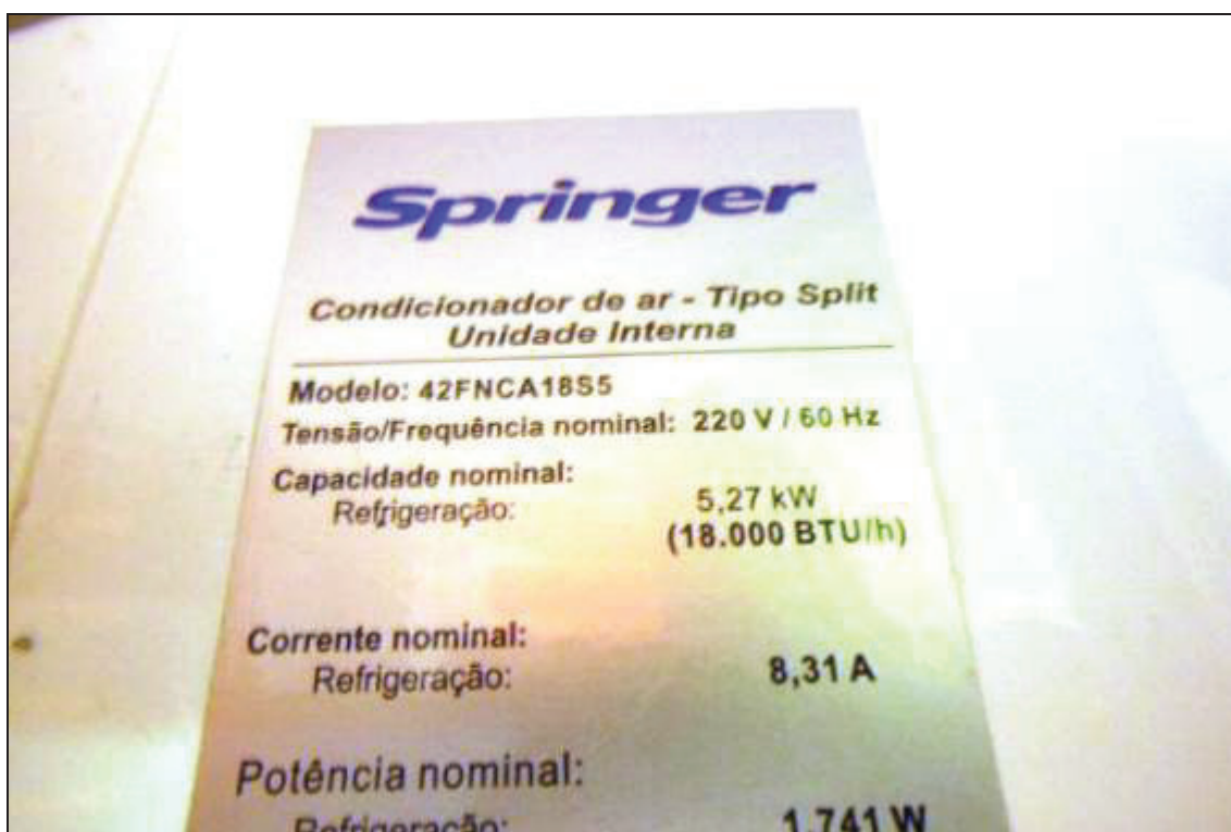
ITEM 1,013 – VISTA DA ETIQUETA DE IDENTIFICAÇÃO DO AR CONDICIONADO MARCA: SPRINGER CARRIER MODELO: SPLIT HI WALL POTÊNCIA: 22.000BTU SÉRIE: 42FNCA18S5
