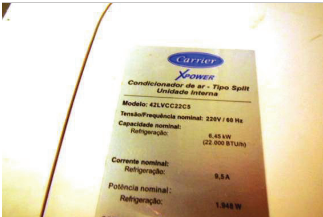
ITEM 1,012 – VISTA DA ETIQUETA DE IDENTIFICAÇÃO DO AR CONDICIONADO MARCA: SPRINGER CARRIER MODELO: SPLIT HI WALL POTÊNCIA: 18.000BTU SÉRIE: 42LVCC22C5
