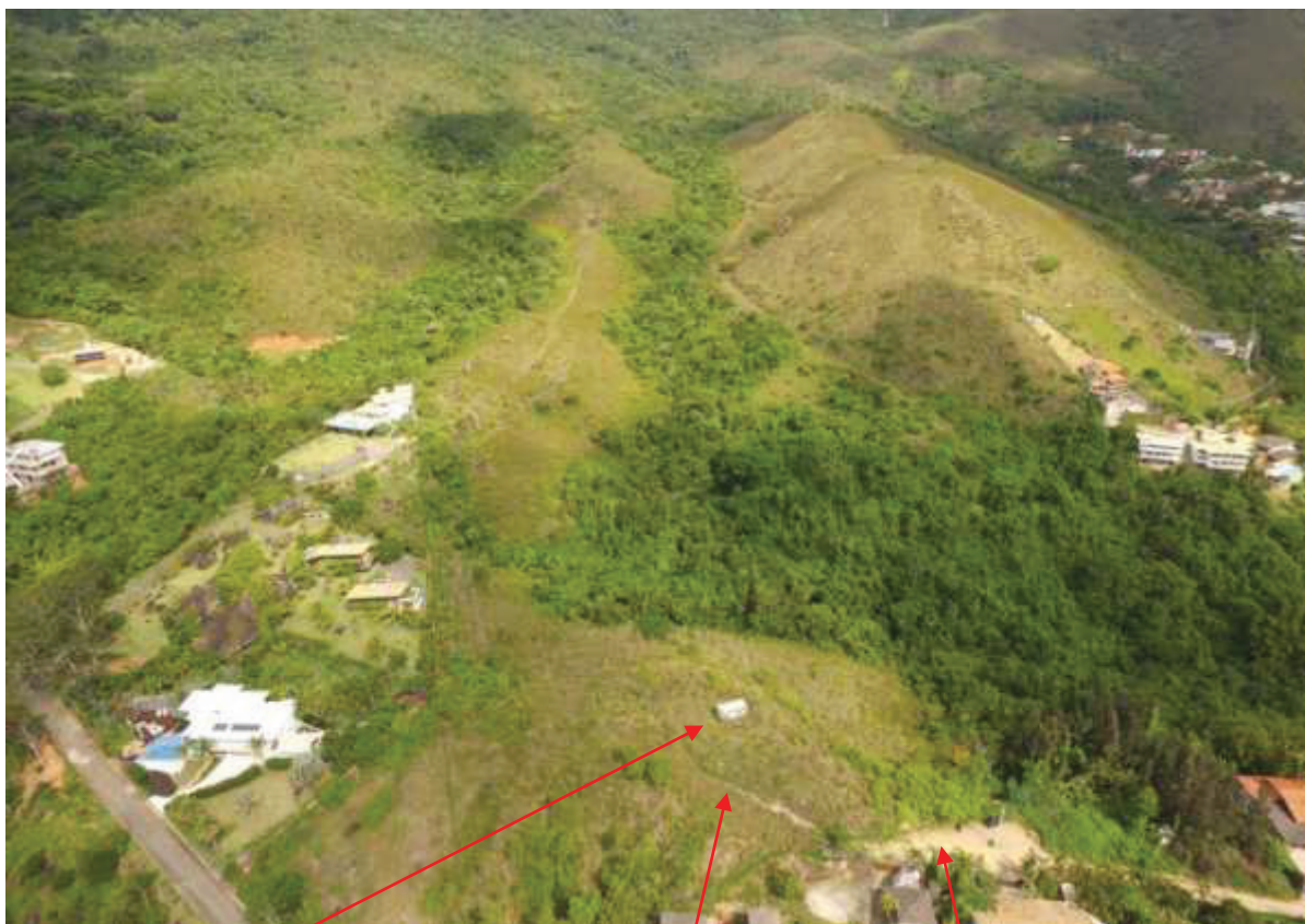
Container metálico observado no local
