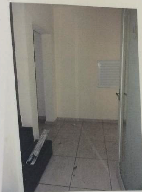
VISTA DO ACESSO À ESCADA AO PISO SUPERIOR.
