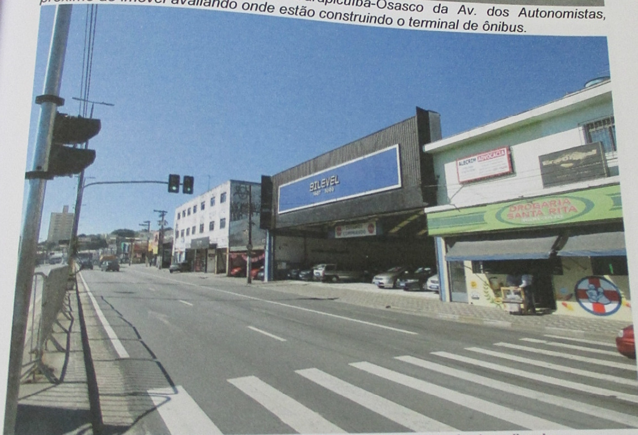
Vista da pista da Av. Autonomista do lado do imóvel avaliando.
