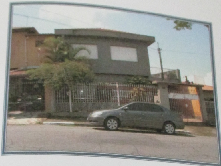
Vista da frente do imóvel avaliando.
