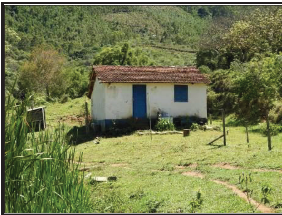
Edificação residencial 06 ( casa de colonos 06 ).
