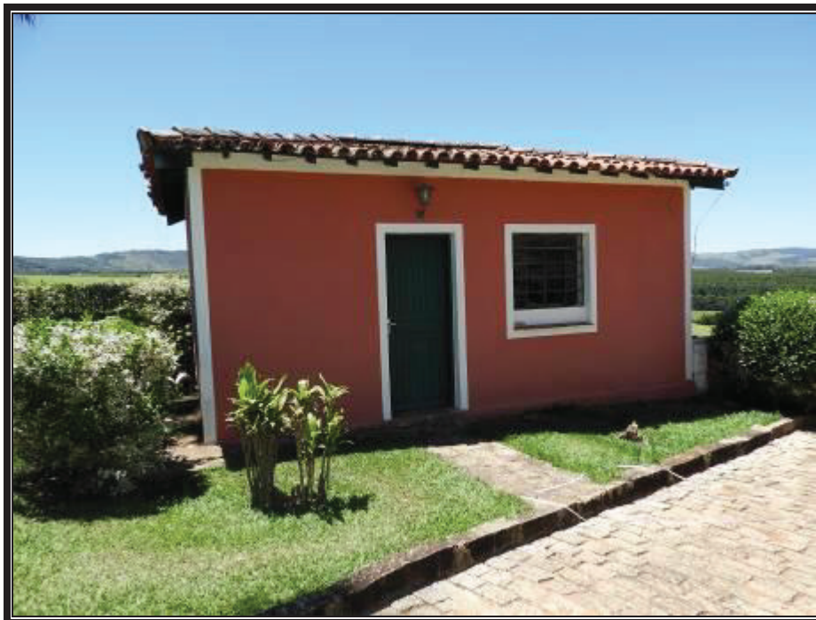
Edificação de apoio / serviços 05 ( escritório )
