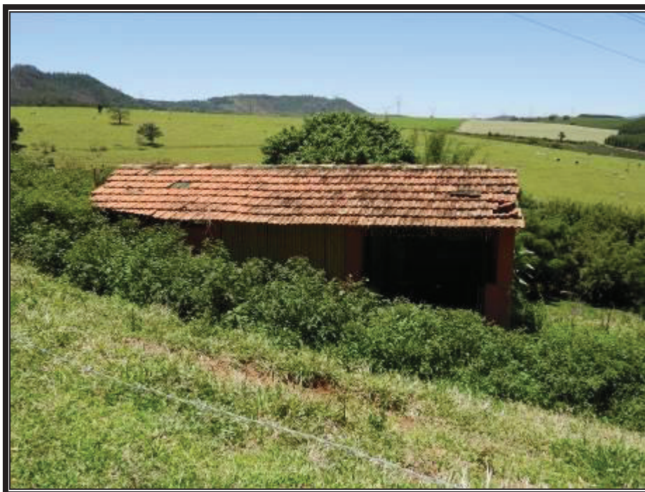
Edificação de apoio / serviços 07 ( criação de coelhos )
