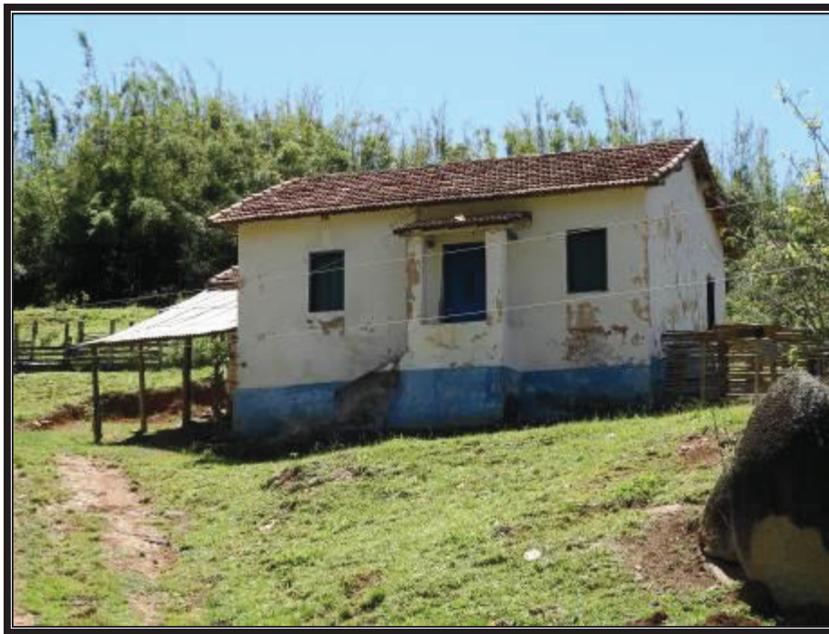
Edificação residencial 05 ( casa de colonos 05 ).
