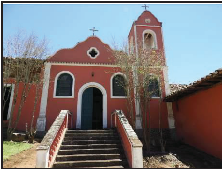
Edificação de apoio / serviços 03 ( capela ).
