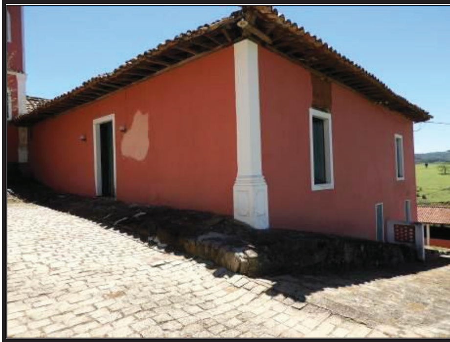
Edificação de apoio / serviços 04 ( depósito ).
