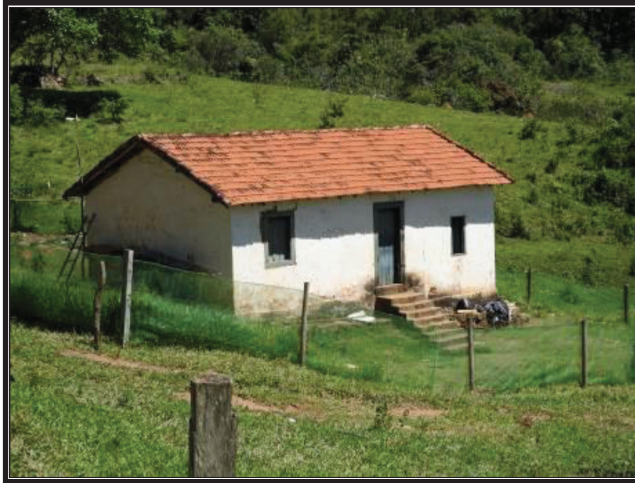
Edificação residencial 03 ( casa de colonos 03 ).
