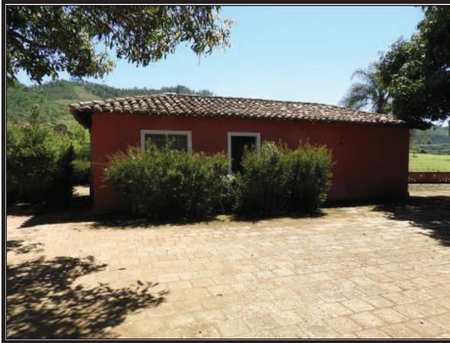
Edificação de apoio / serviços 02 ( lavanderia ).
