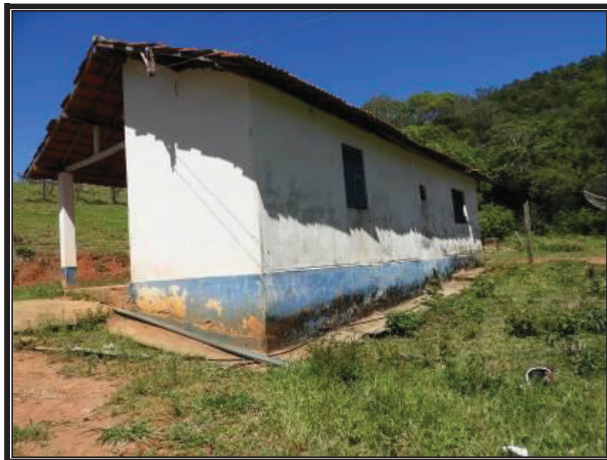
Edificação residencial 02 ( casa de colonos 02 ).
