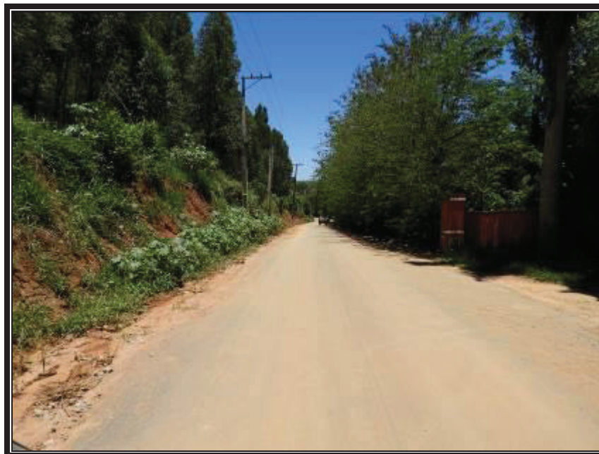
Vista da Estrada Municipal que dá acesso ao imóvel avaliando.
