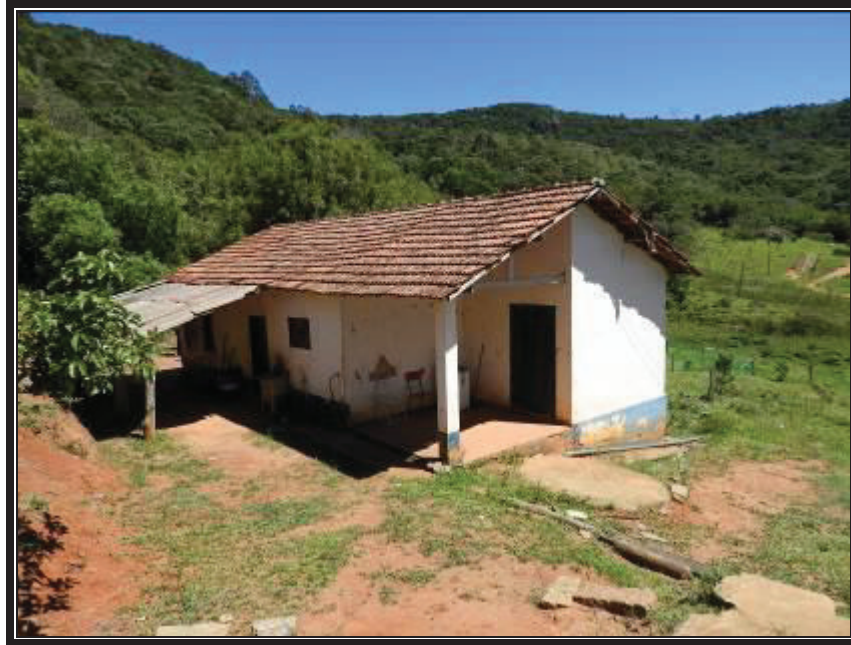
Edificação residencial 01 ( casa de colonos 01 ).
