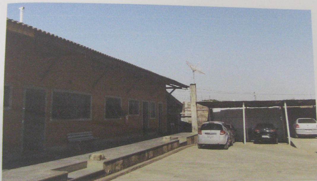
Garagem de veículos.
