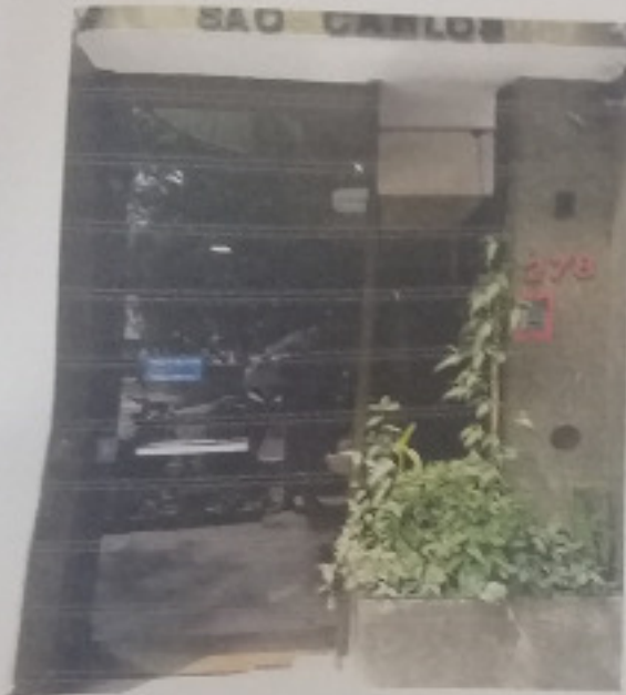
PORTARIA DO EDIFÍCIO
