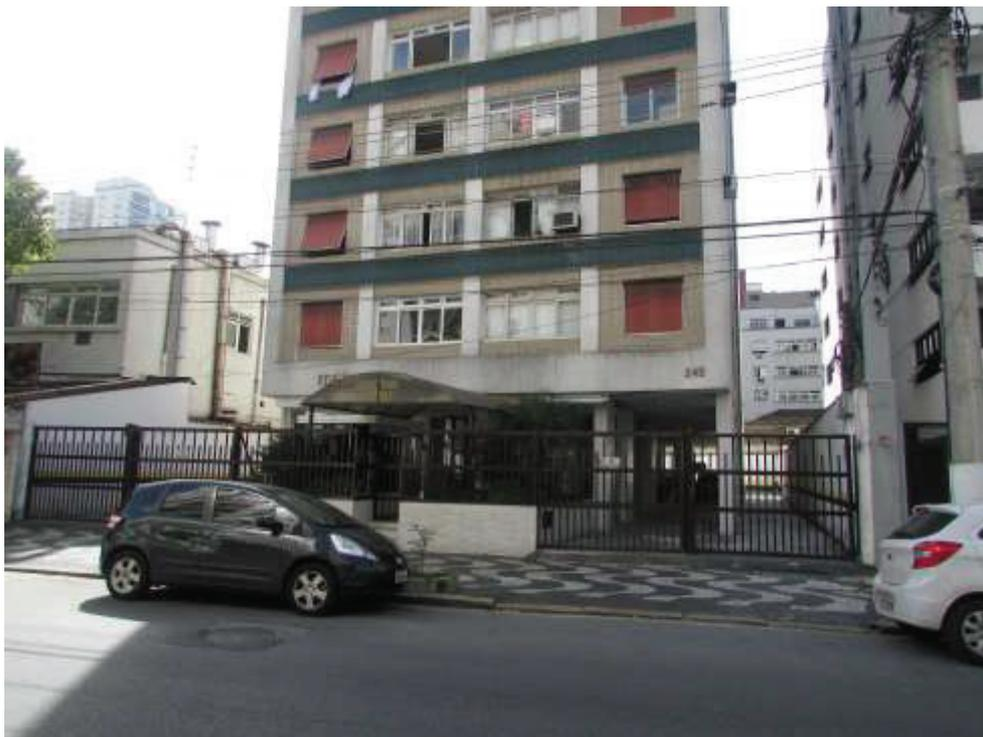
Acima, temos a vista externa do referido edifício o qual nota-se as paredes revestidas de massa fina pintada, com janelas de vidro e caixilhos de alumínio.
