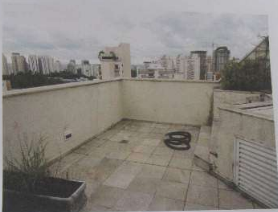
Foto nº 25 – Vista do terraço.
