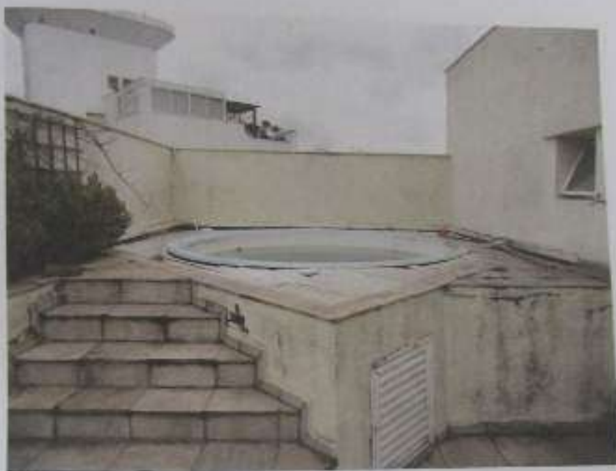
Foto nº 26 – Vista da piscina.
