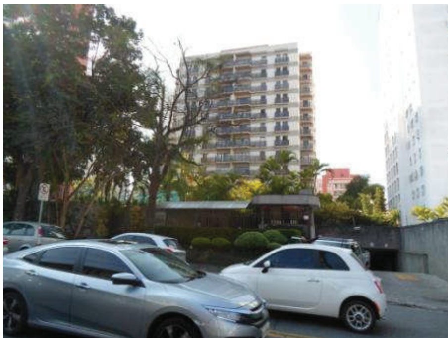
Vista da fachada do condomínio.
