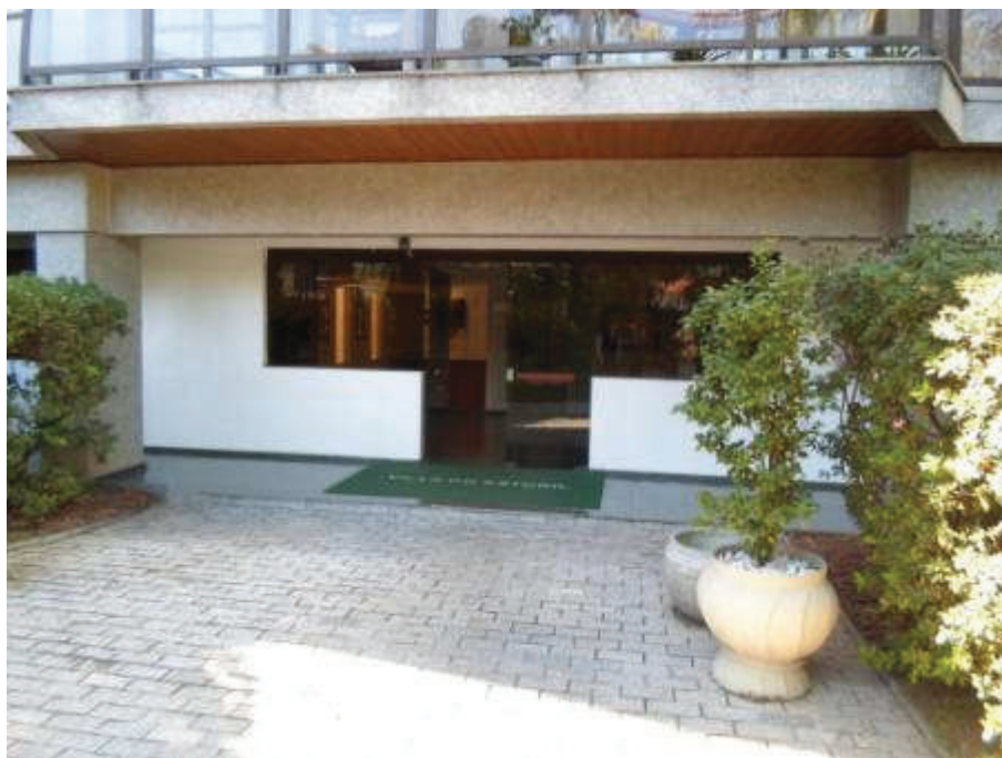
Vista da entrada do prédio
