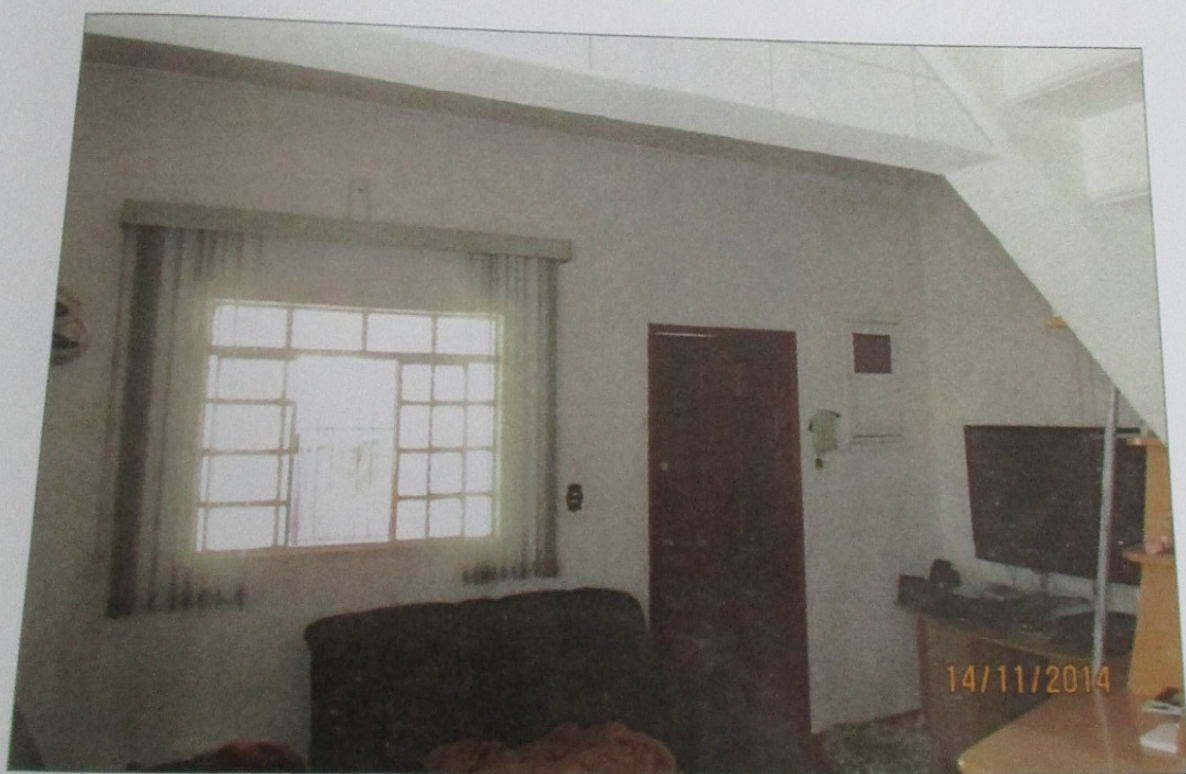
Foto 6) Vista do interior da sala do imóvel. Observar acabamento de paredes e teto, caixilho metálico "de correr" e porta envernizada.
