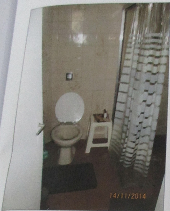
Foto 9) Vista do banheiro. Observar piso cerâmico, paredes revestidas por azulejos até o teto e bacia sanitária com válvula de descarga.
