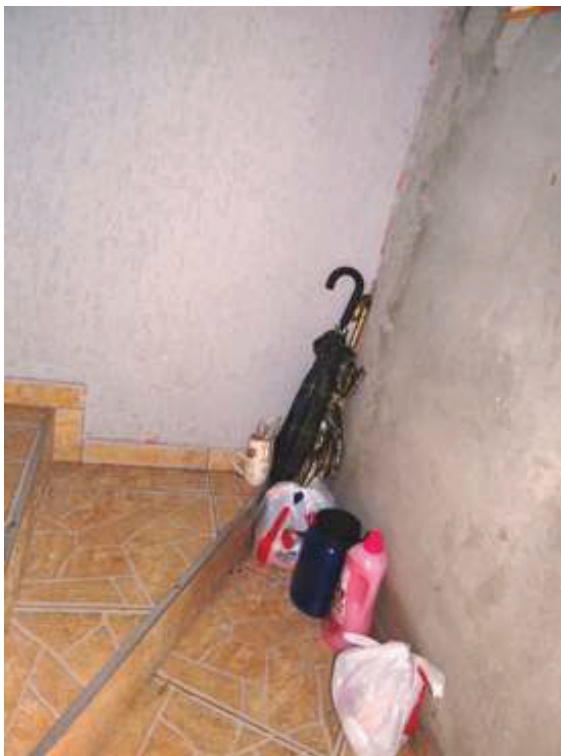
Foto 16: Vista Escada de acesso ao Piso Superior
