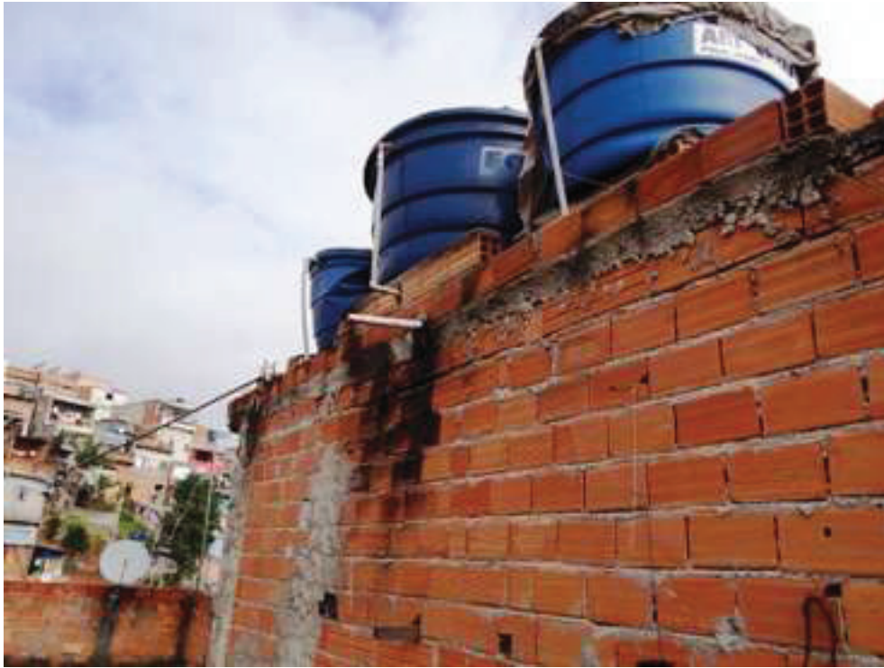
Foto 37: Vista Escada de acesso à laje de cobertura.
