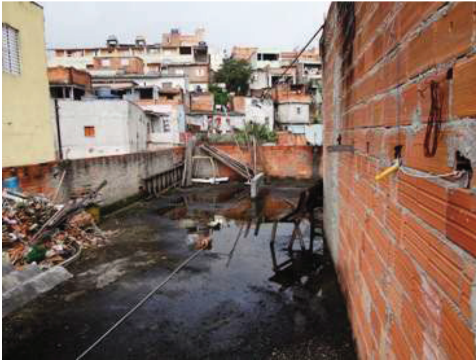
Foto 35: Vista Escada de acesso à laje de cobertura.
