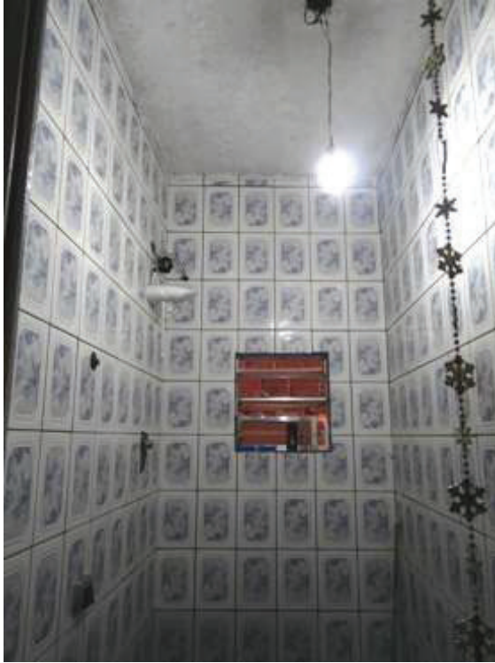
Foto 47: Vista WC Casa Inferior
