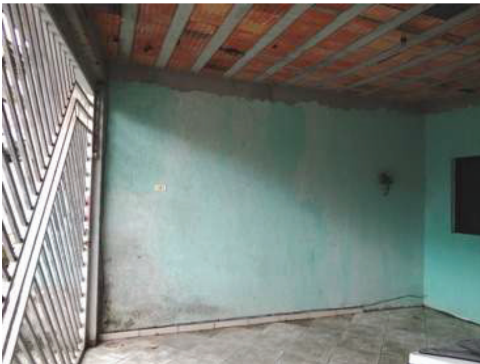
Foto 5: Piso térreo - Vista Garagem
