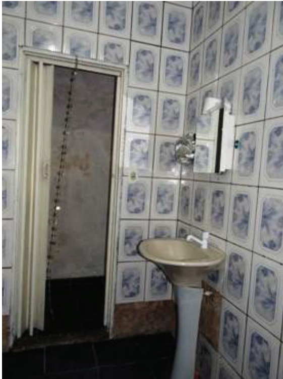
Foto 49: Vista WC Casa Inferior
