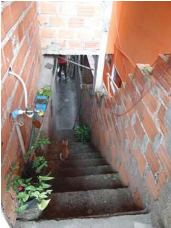
Foto 39: Vista Escada de acesso ao piso inferior.
