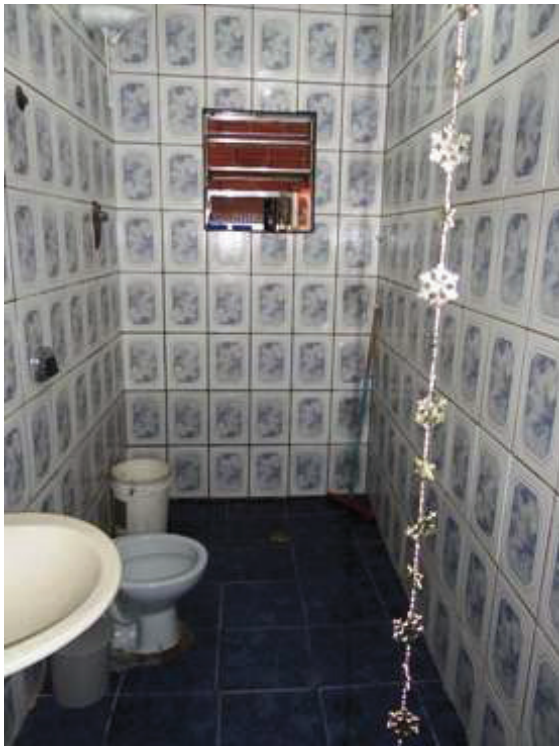
Foto 48: Vista WC Casa Inferior
