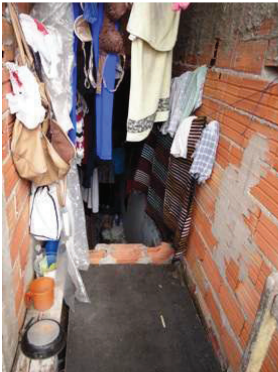
Foto 38: Vista Escada de acesso à laje de cobertura.
