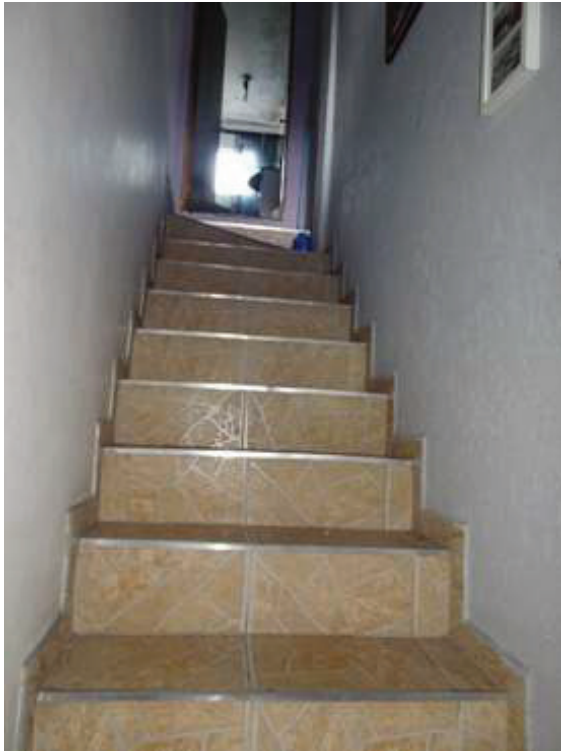
Foto 17: Vista Escada de acesso ao Piso Superior
