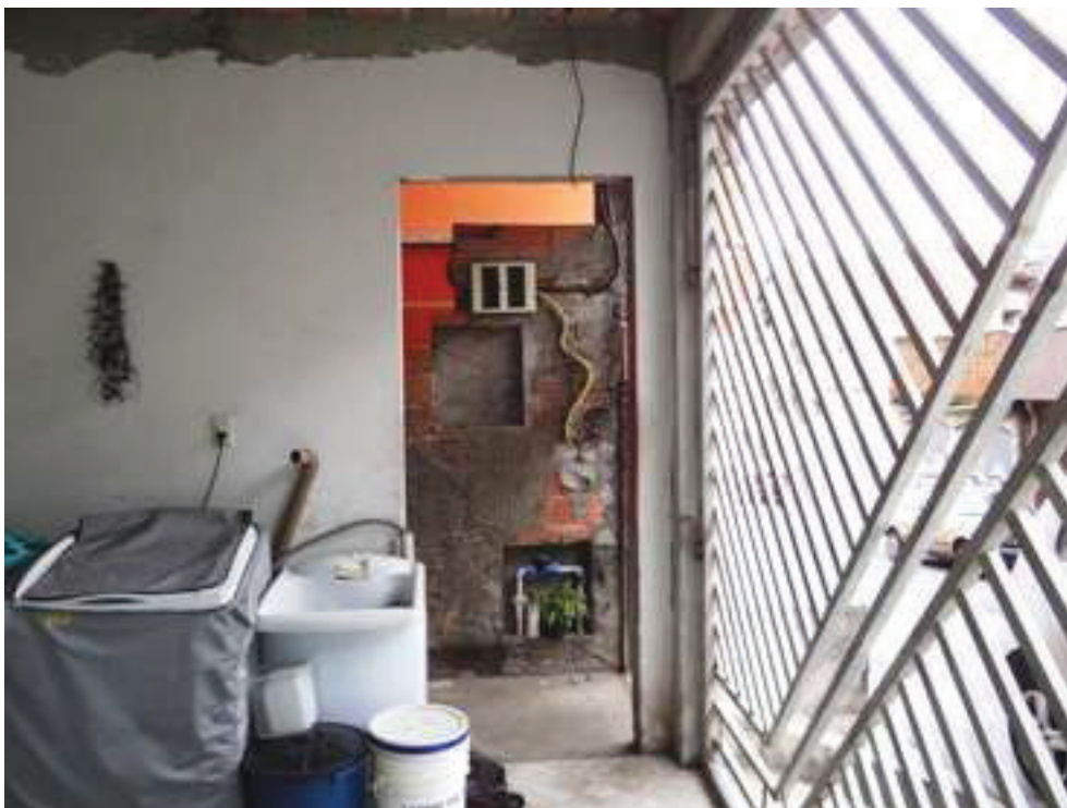
Foto 6: Piso térreo - Vista Garagem
