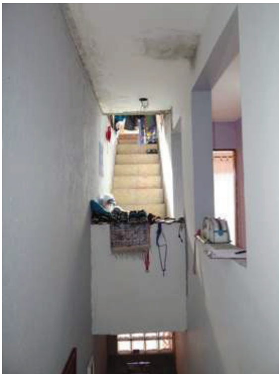
Foto 32: Piso Superior - Vista Escada Laje
