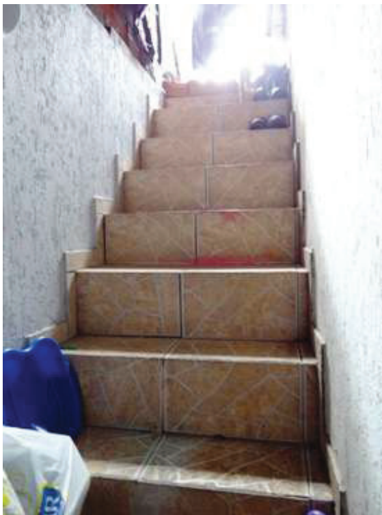
Foto 34: Vista Escada de acesso à laje de cobertura.
