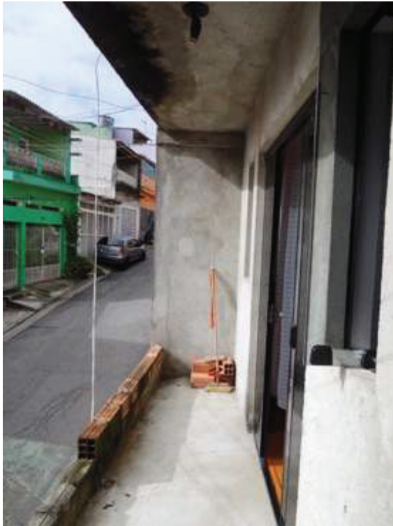
Foto 31: Piso Superior - Vista Varanda Piso Superior
