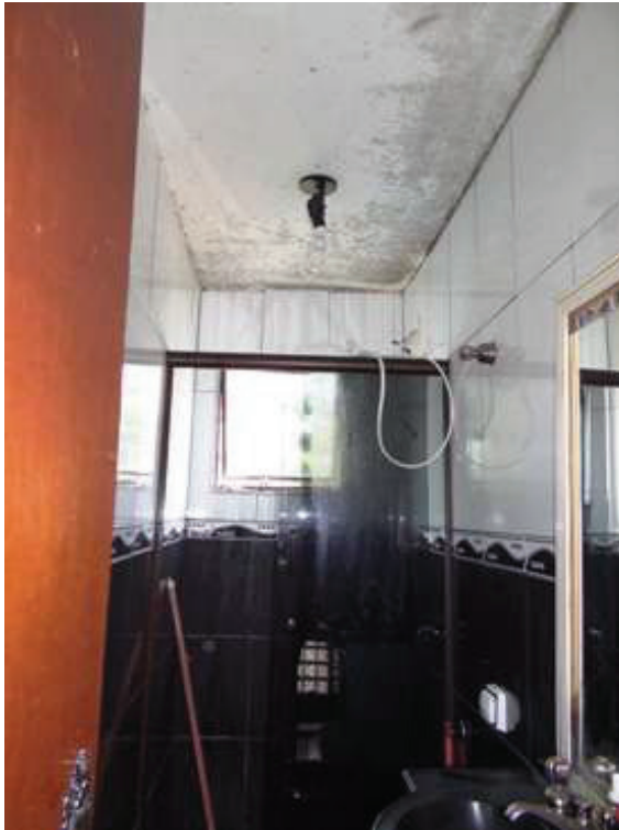
Foto 19: Piso Superior - Vista WC
