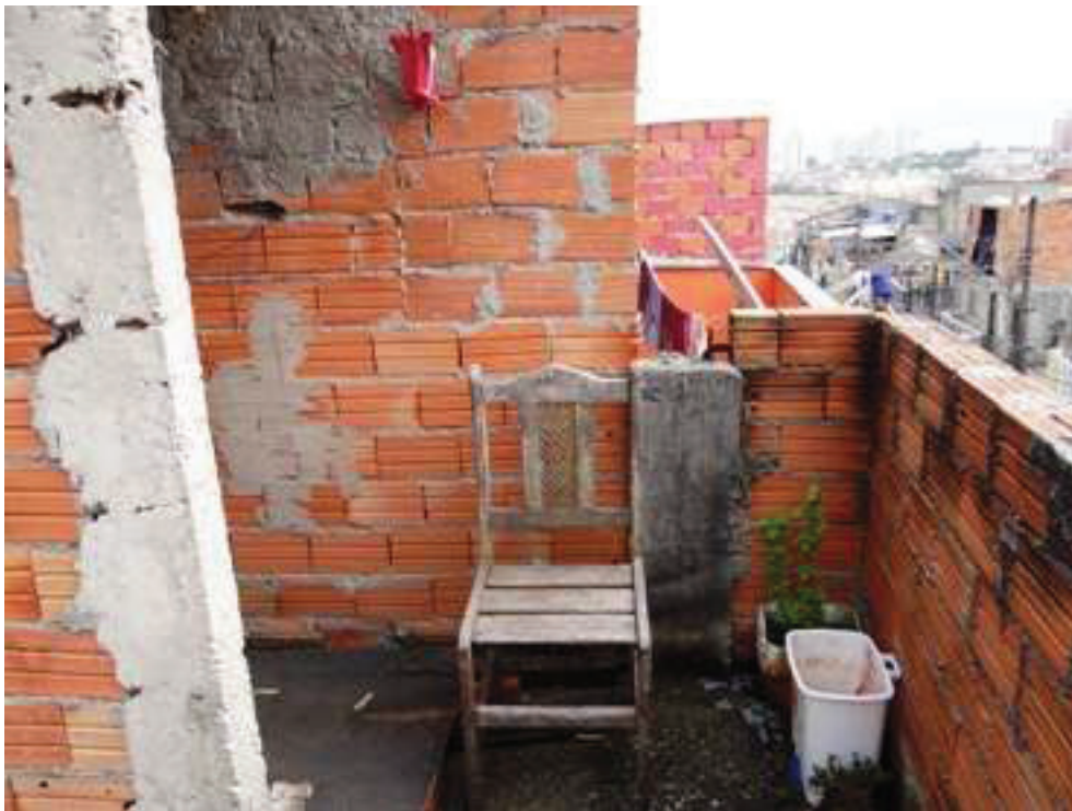
Foto 36: Vista Escada de acesso à laje de cobertura.
