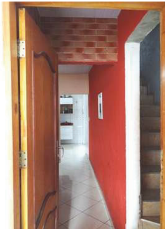
Foto 8: Piso térreo - Vista Entrada Imóvel
