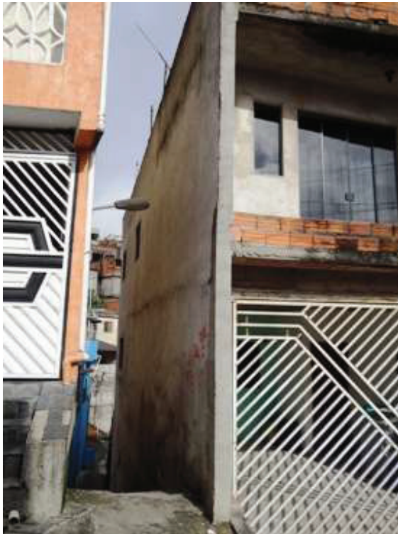
Foto 2: Vista Lateral Imóvel
