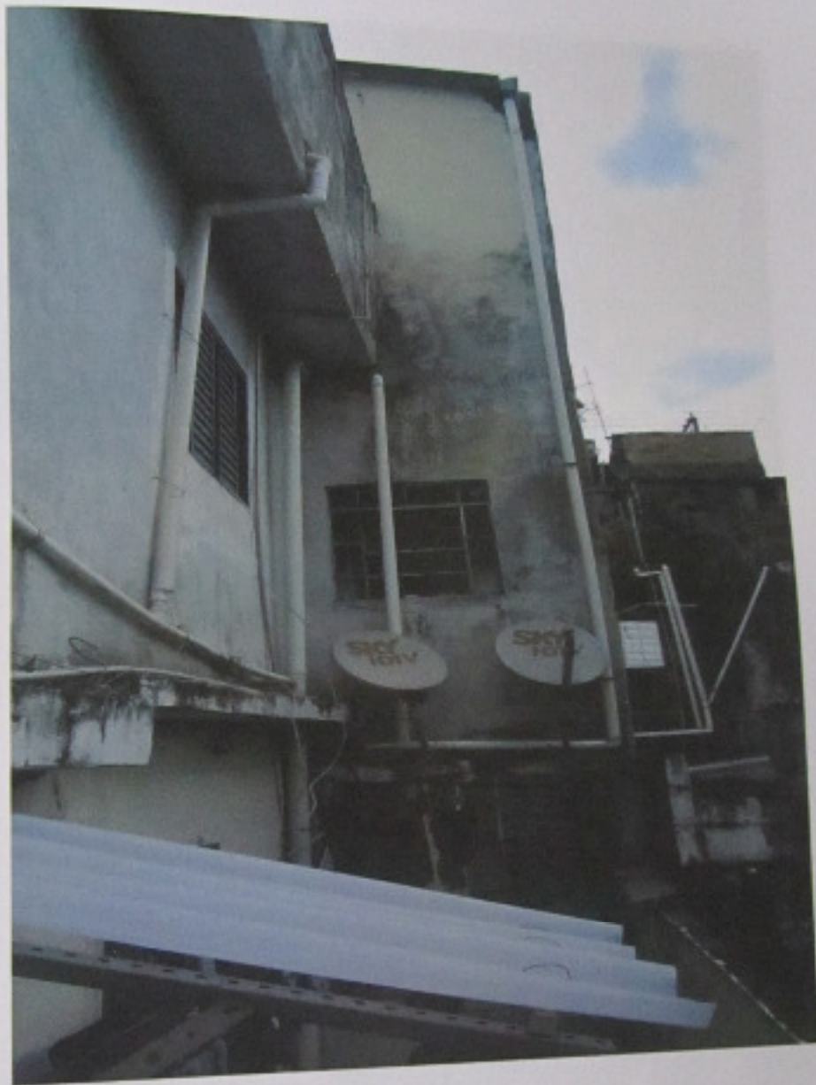
Foto 7 – Foto do corredor tirada do fundo do terreno
