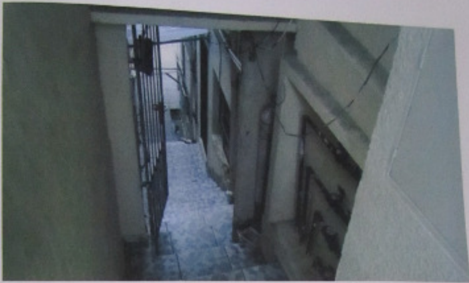
Foto 3 – Foto da escada da entrada.
