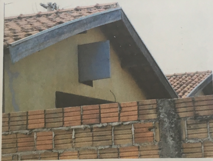
Foto 08 – Mostrando detalhe da parede dos fundos e seu nível construtivo.
