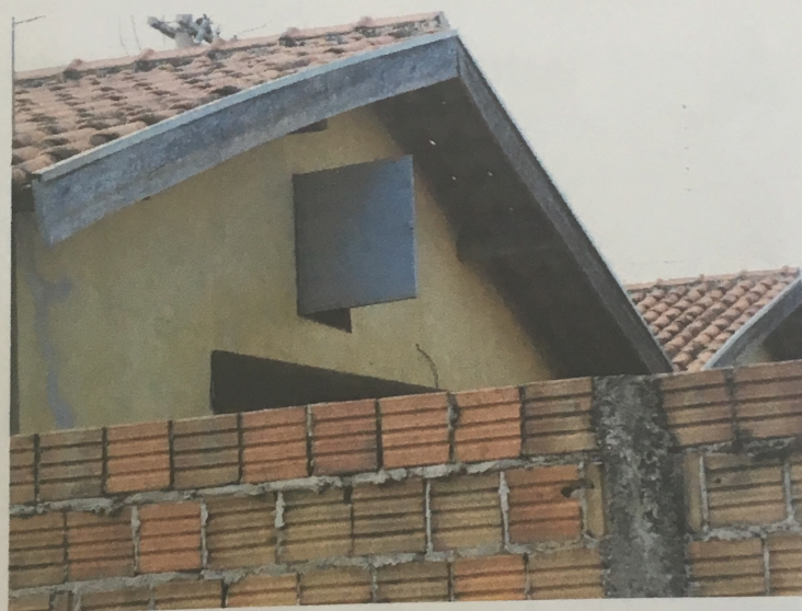
Foto 08 – Mostrando detalhe da parede dos fundos e seu nível construtivo.
