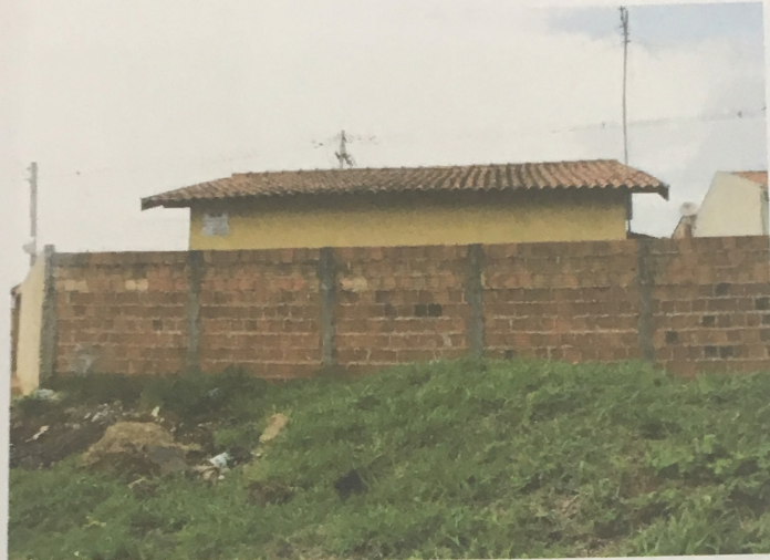
Foto 07 – Mostrando uma das laterais do imóvel e confrontação com terreno vago.
