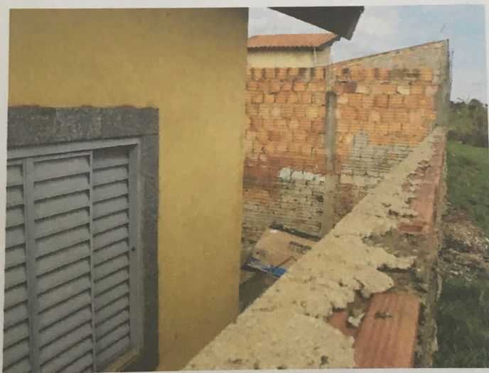
Foto 10 – Mostrando uma visão da parede lateral e parte do quintal dos fundos.
