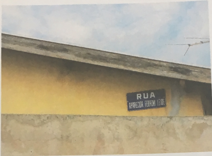
Foto 05 – Mostrando a placa identificatória da via pública na parede do próprio imóvel avaliando.
