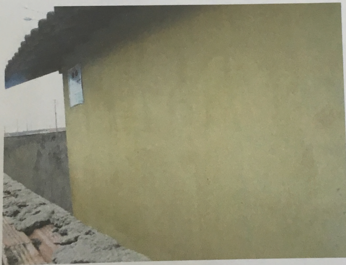
Foto 12 – Mostrando uma outra visão da parede lateral da casa e seu nível construtivo.
