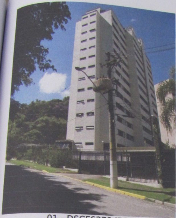
01 - DSCF6370.JPG Edifício Araguaia.
