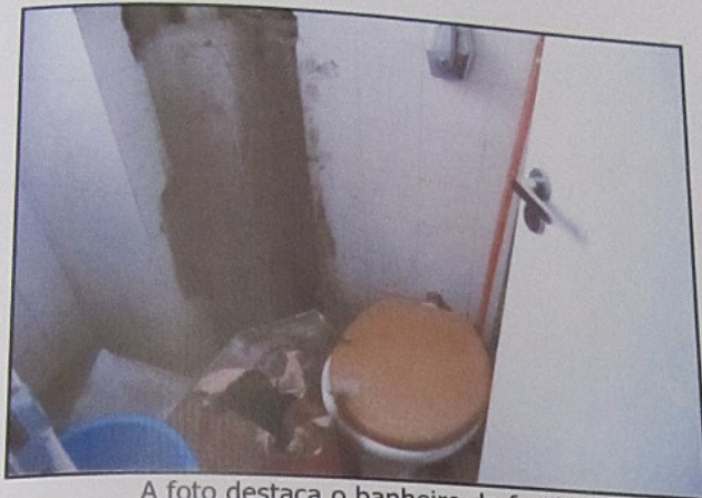
A foto destaca o banheiro do fundo.
