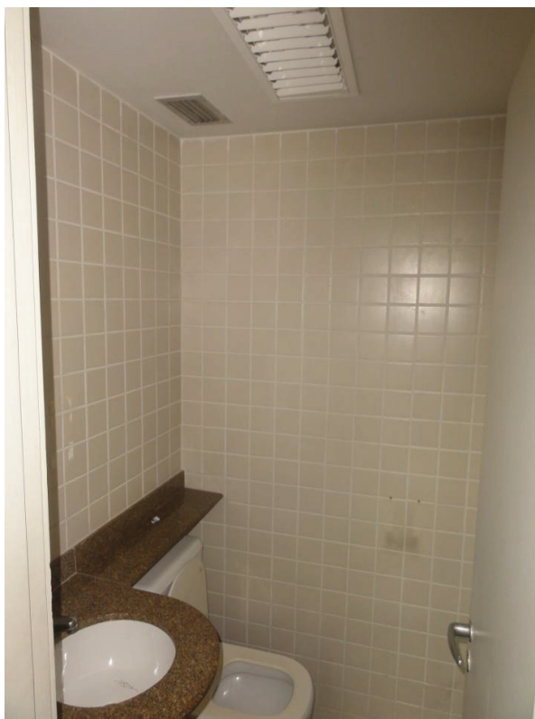
VISTA DO PRIMEIRO BANHEIRO.
