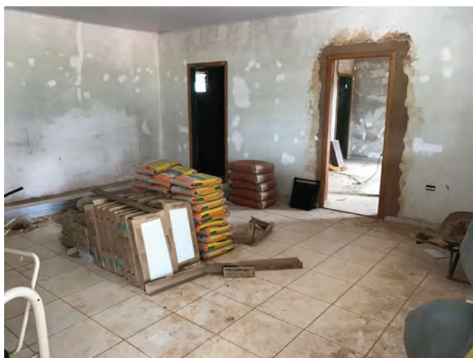
↑ Casa de funcionário em reforma - Interno
