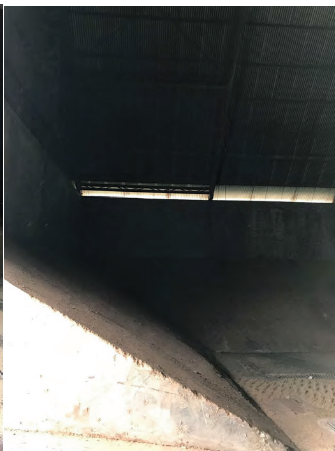
↑ Estrutura interna do armazém
