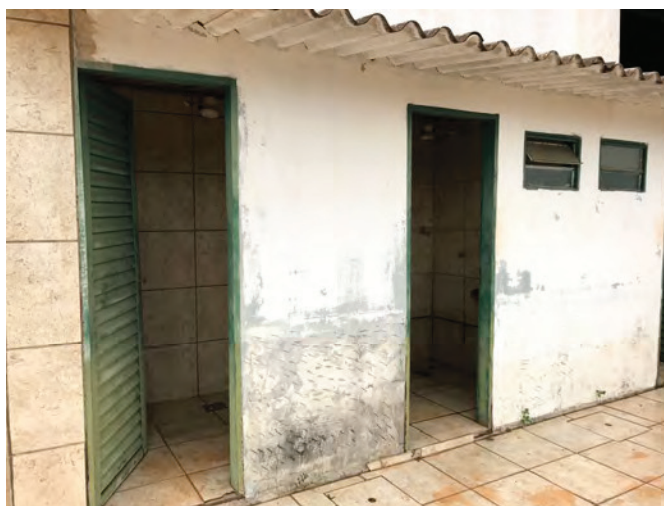
↑ Banheiro dos funcionários - Armazem
