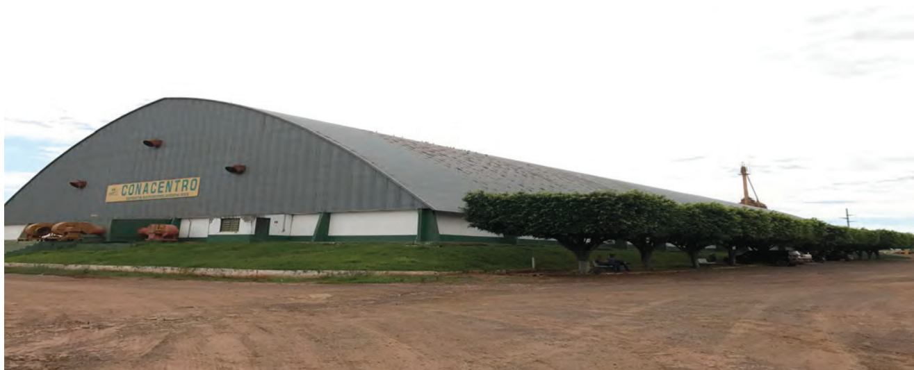
↑ Armazém Principal – Lateral Direita
