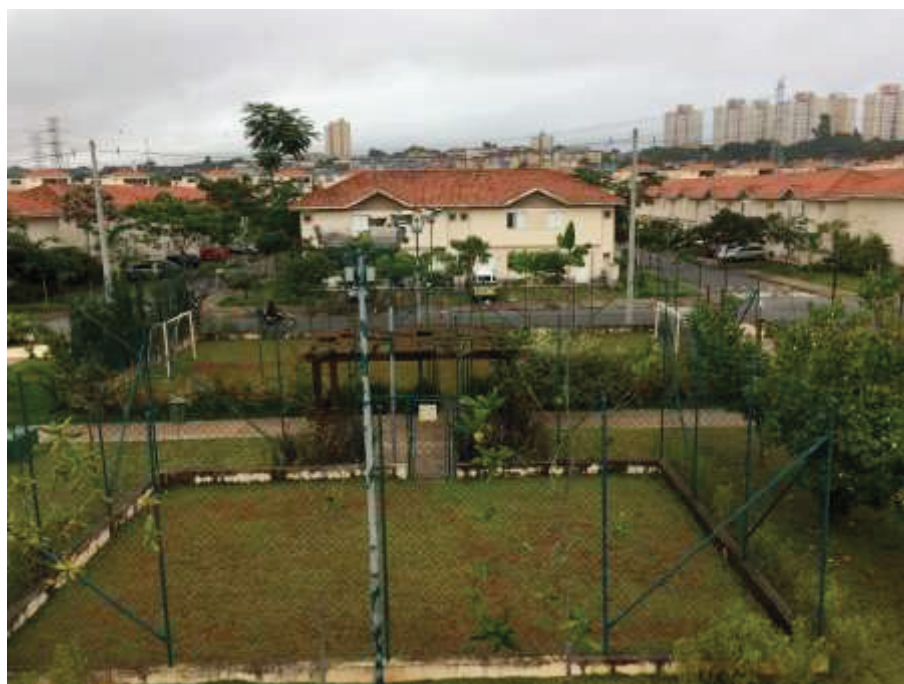
Figura 9 - Vista das Townhouses - Fonte:Autor
