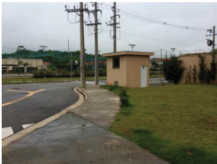
Figura 5 - Vias internas do condomínio - Fonte:Autor
