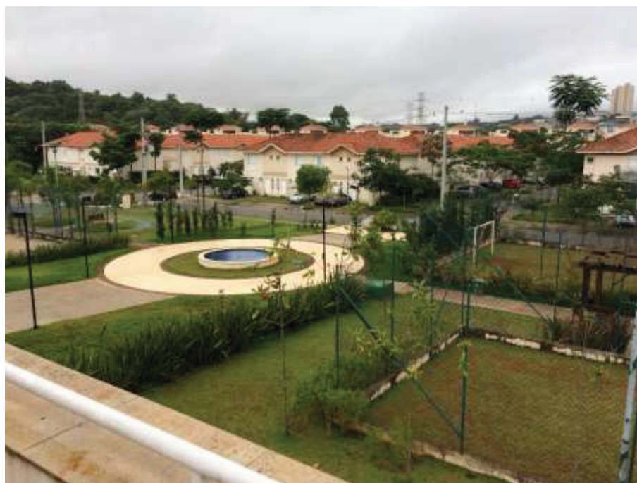
Figura 8 - Vista das Townhouses - Fonte:Autor
