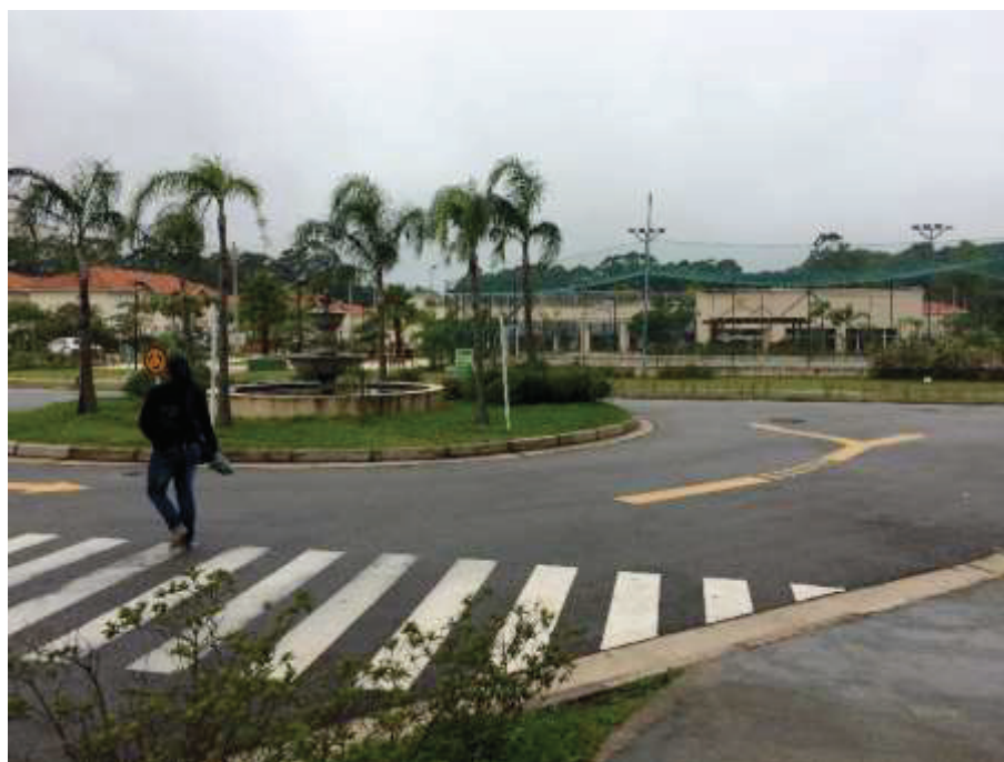
Figura 6 - Vias internas do condomínio - Fonte:Autor
