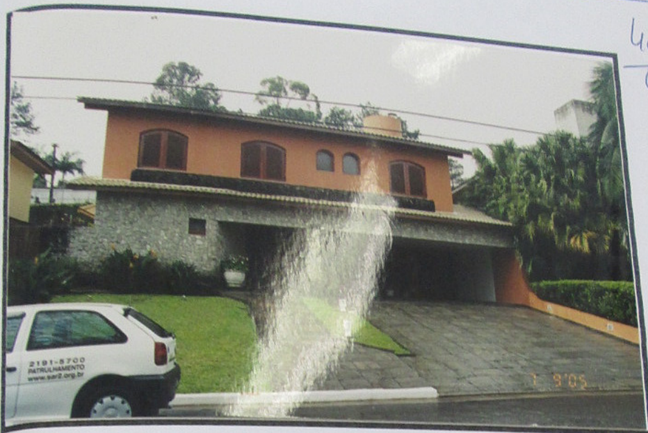
Foto: Proost FOTO 01 – Vista do imóvel avaliando localizado à Rua Argentina, nº 338, Alphaville II, município de Barueri, lote cujo fundos é para o muro externo com a Avenida Alphaville.
