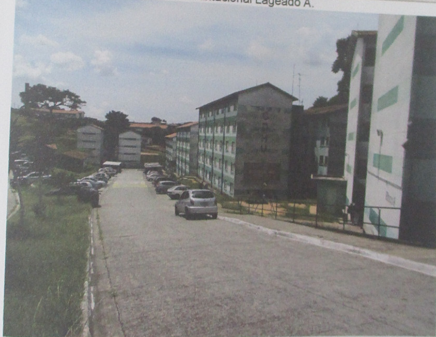
Foto 3: Vista do Conjunto Habitacional Lageado A.
