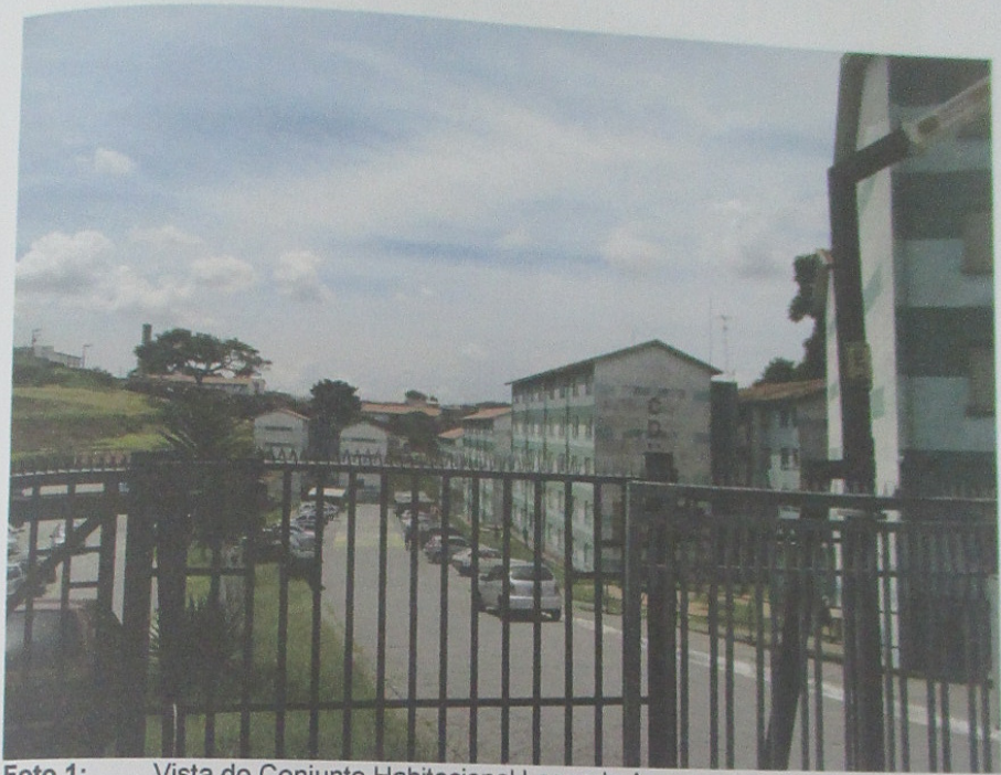
Foto 1: Vista do Conjunto Habitacional Lageado A.
