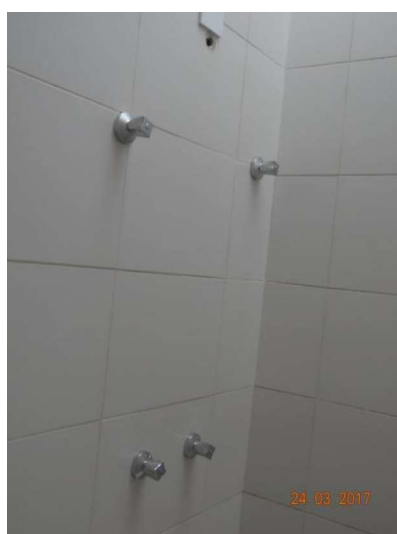
Piso superior: banheiro social padrão – pia em mármore travertino; sem box e sem chuveiro
