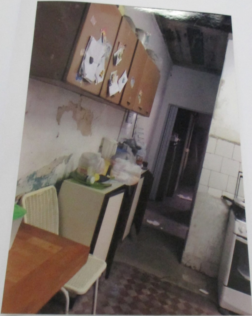
Foto Parede da cozinha
