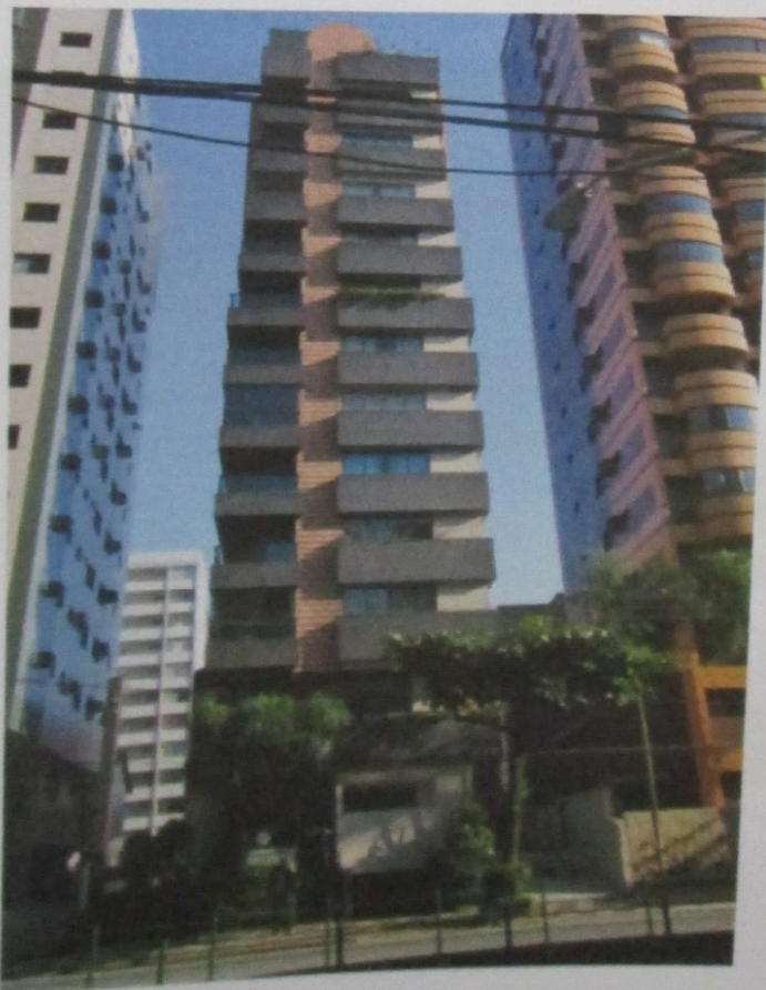
FOTO 01 :- Vista do imóvel.
