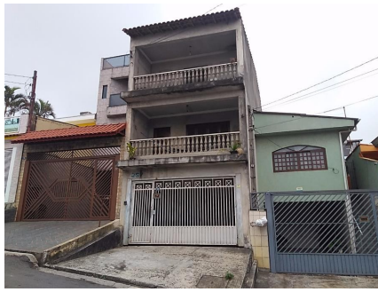
Representação Fachada Descrição Data Foto 01/12/2017
