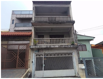
Representação Fachada Descrição Data Foto 01/12/2017
