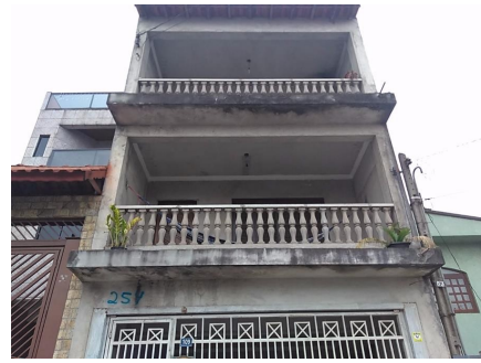
Representação Fachada Descrição Data Foto 01/12/2017
