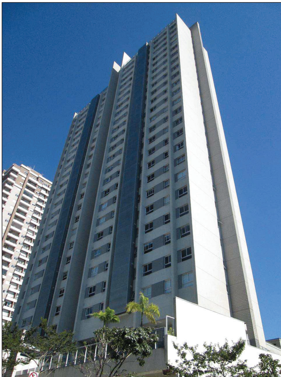
Vista do empreendimento
