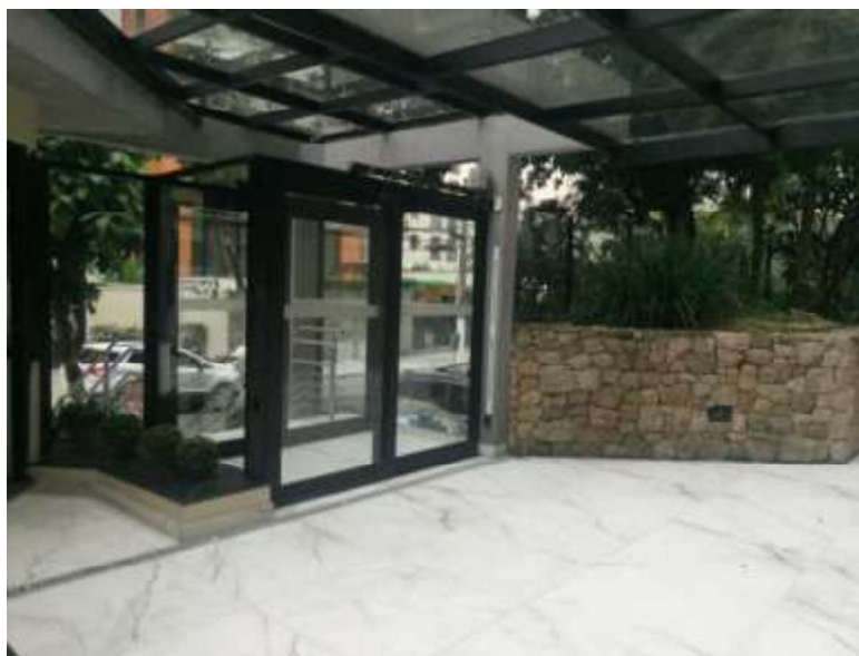
DETALHE DAS CARACTERÍSTICAS CONSTRUTIVAS DA ENTRADA SOCIAL.
