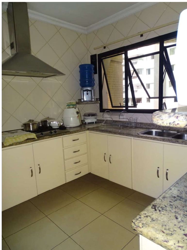
DETALHE DAS CARACTERÍSTICAS CONSTRUTIVAS DA COZINHA.
