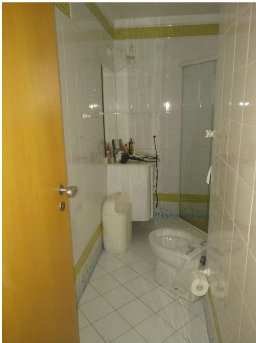
DETALHE DAS CARACTERISITICAS CONSTRUTIVAS DO BANHEIRO DA SUITE 3.
