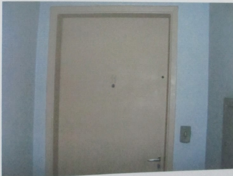
FOTO 04 - ENTRADA PARA O APARTAMENTO DE Nº 11 1º ANDAR
