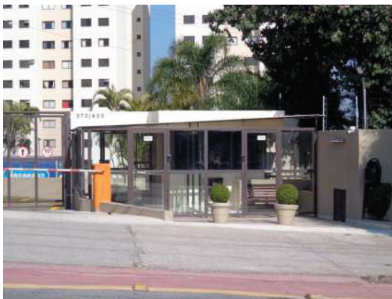
FOTOS N° 03/04 : Vista do hall de entrada do Edifício Sabagga.
