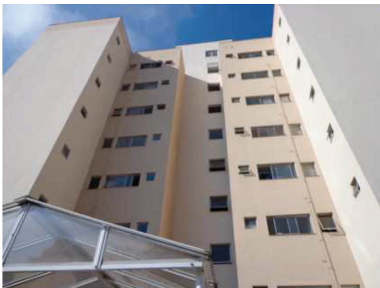
FOTOS N° 05/06: Vista da calçada, no trecho fronteiro ao Edifício Sabagga.
