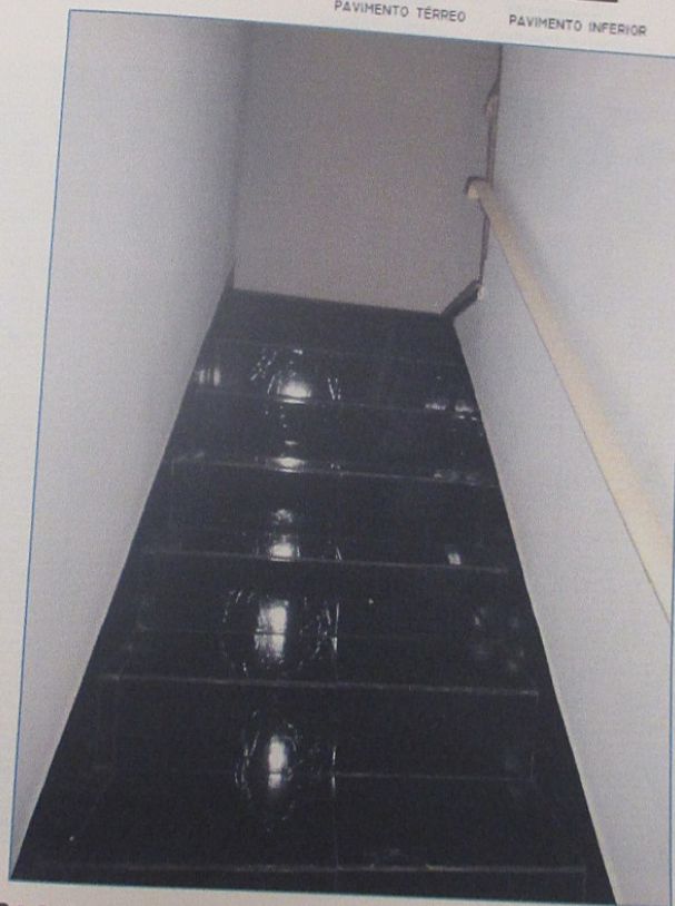
ESCADA DE ACESSO AO PAVIMENTO SUPERIOR.
