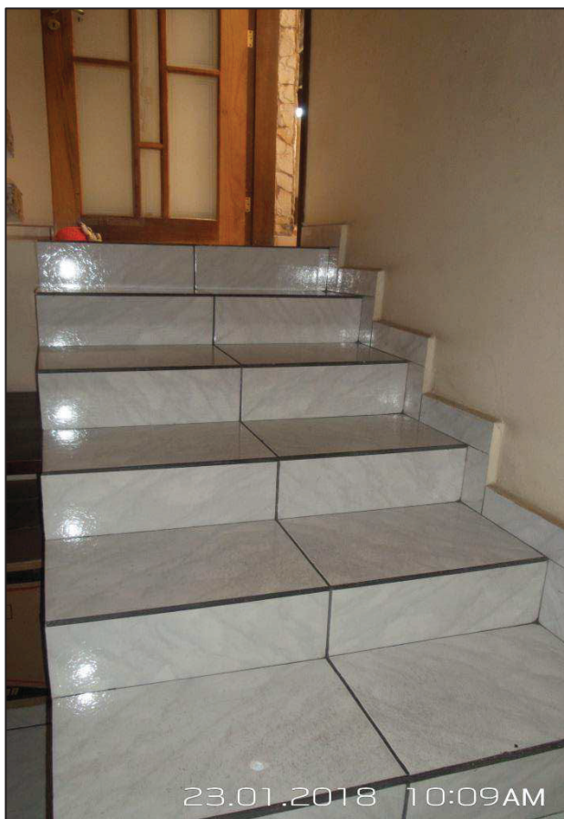
ACESSO AOS DORMITÓRIOS
