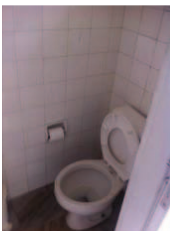
Foto 20: Vaso sanitário do vestiário.
