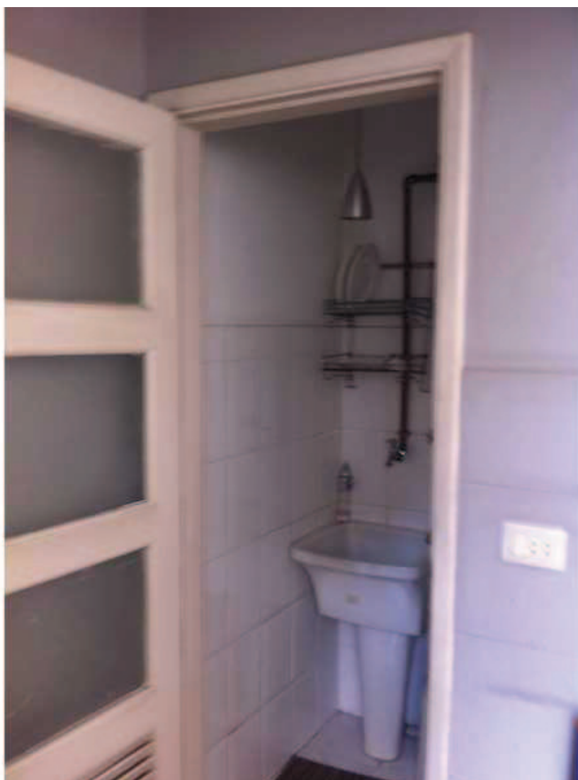
Foto 28: Detalhe do banheiro de serviço transformado em copa.
