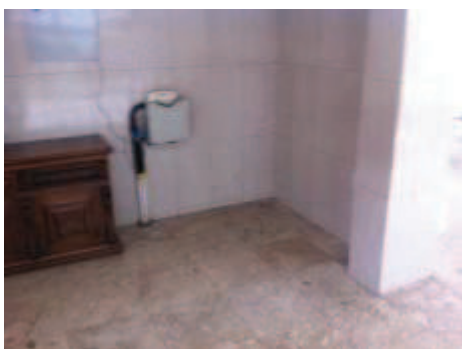
Foto 10: Hall de entrada do edifício.
