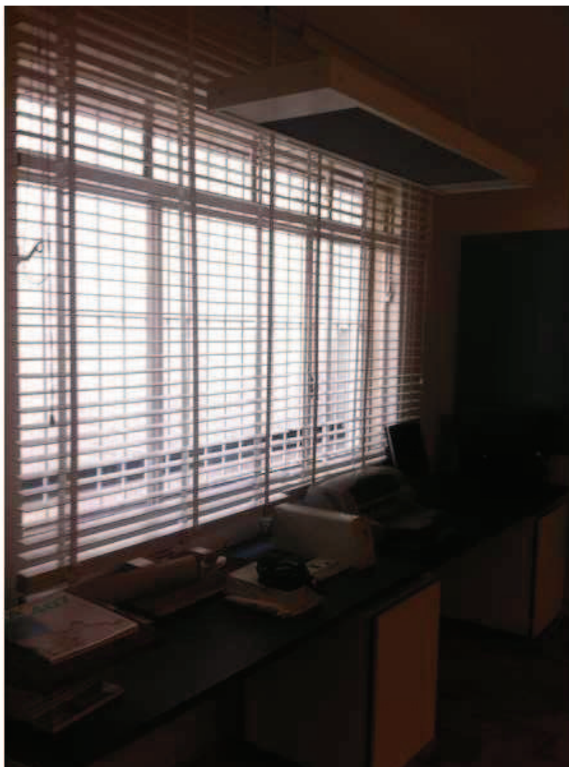
Foto 16: Detalhe do caixilho da sala.
