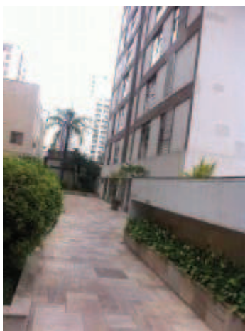
Foto 7: Entrada lateral do edifício.
