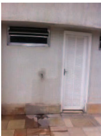
Foto 18: Entrada do vestiário próxima à piscina.
