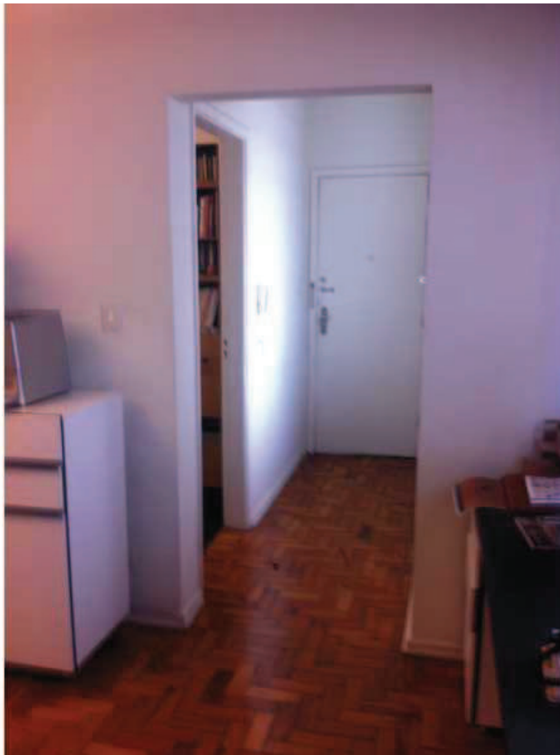
Foto 11: Vista da porta de entrada, a partir da sala da unidade, com detalhe (à esquerda) da porta de acesso à biblioteca, que originalmente era uma cozinha.
