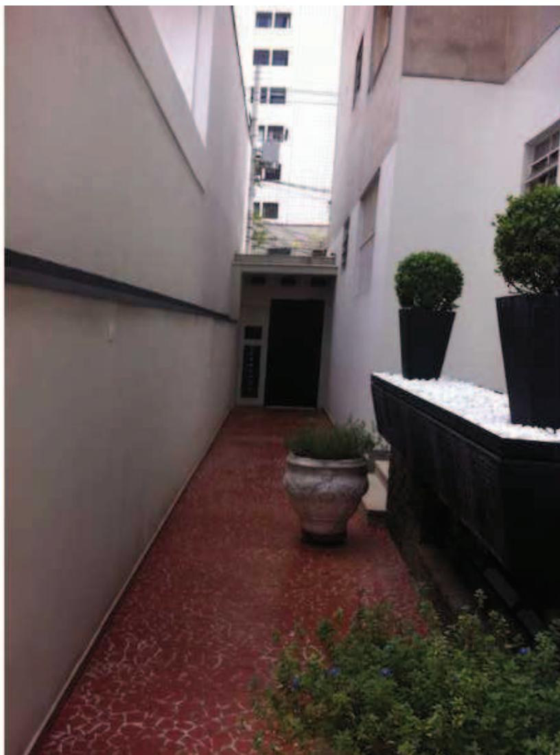
Foto 6: Entrada lateral do edifício, com portão metálico ao fundo.
