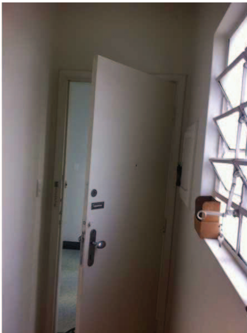
Foto 10: Vista da porta de entrada, a partir da sala da unidade. As janelas estão em bom estado de conservação e em perfeito funcionamento.
