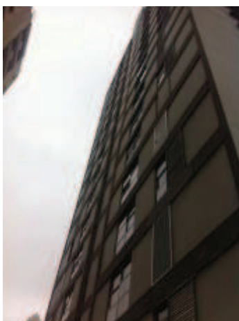
Foto 3: Fachada do Condomínio Edifício Cabo Verde.
