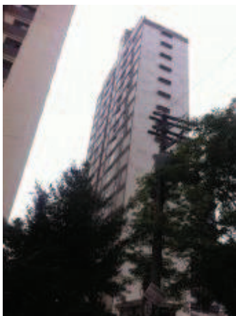
Foto 1: Fachada do Condomínio Edifício Cabo Verde.
