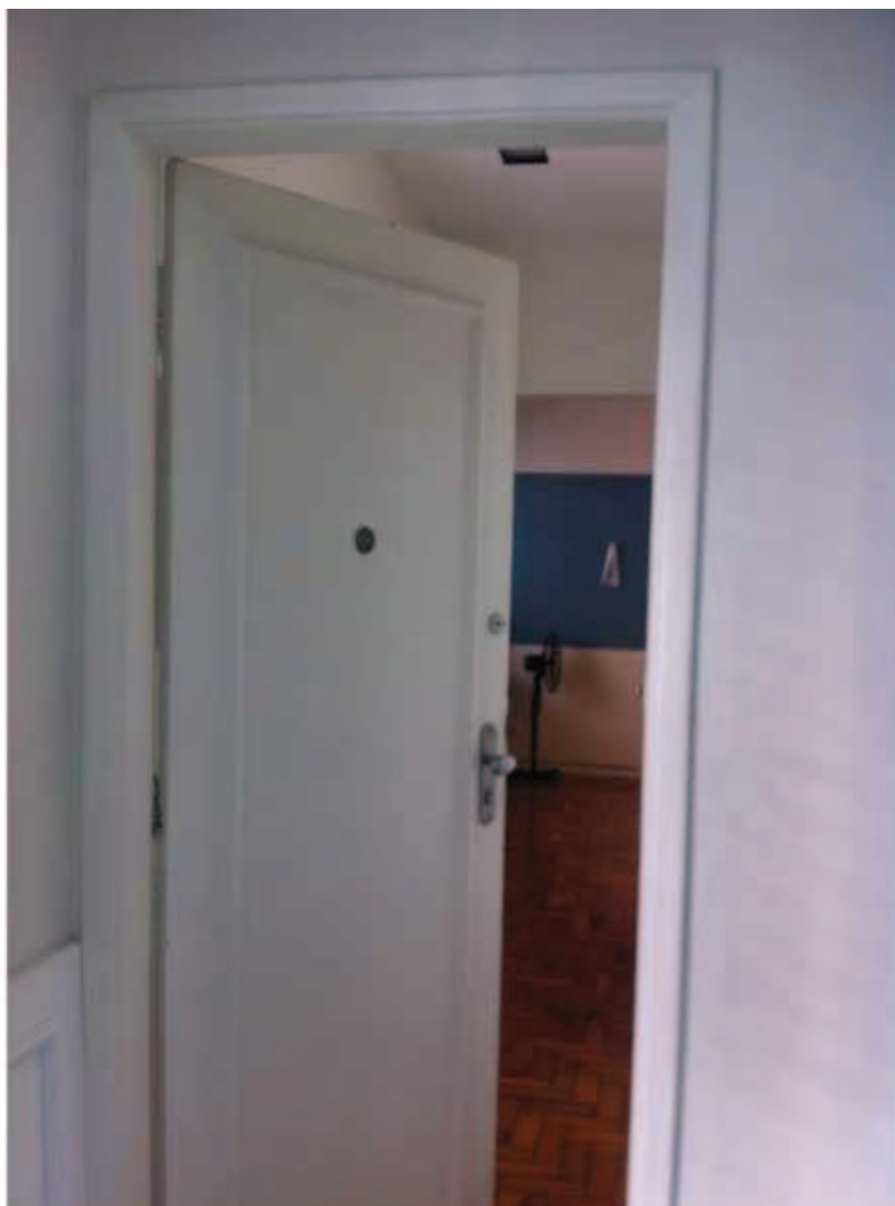
Foto 9: Porta de acesso à unidade, vista a partir do hall de entrada do edifício.
