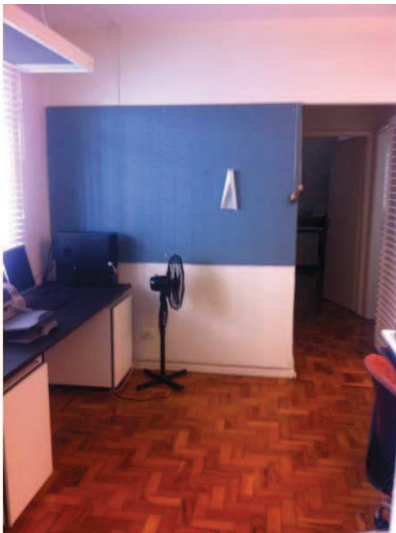
Foto 15: Vista da sala a partir da entrada da unidade. Atenção para o bom estado de conservação do piso, em taco de madeira.
