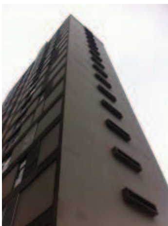
Foto 2: Fachada do Condomínio Edifício Cabo Verde.
