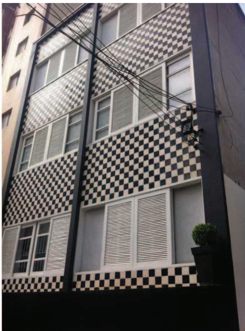
Foto 2: Detalhe da fachada do Edifício Fortunato.
