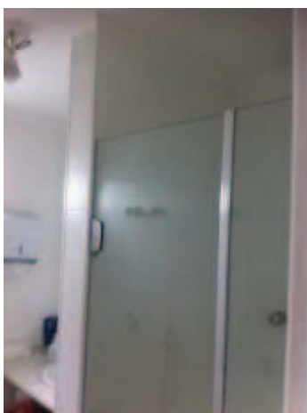
Foto 50: Box do banheiro ao lado do quarto 1. Este é o único banheiro da unidade, à exceção daquele localizado na área de serviço.
