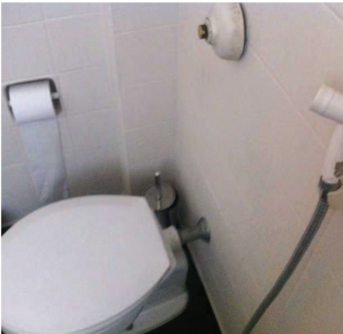
Foto 26: Detalhe de peças sanitárias do banheiro.
