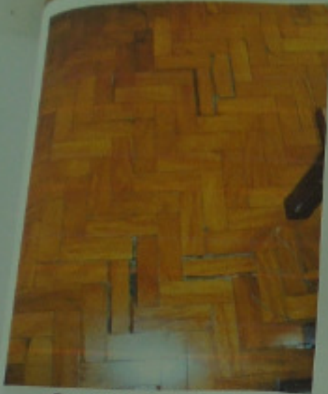
Foto 13 - Detalhe do piso
