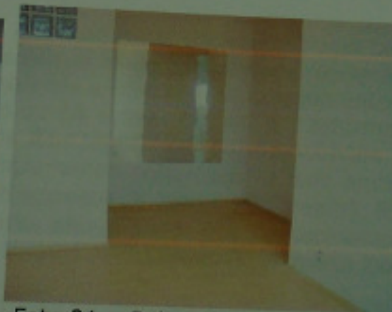
Foto 31 - Sala reformada no piso
