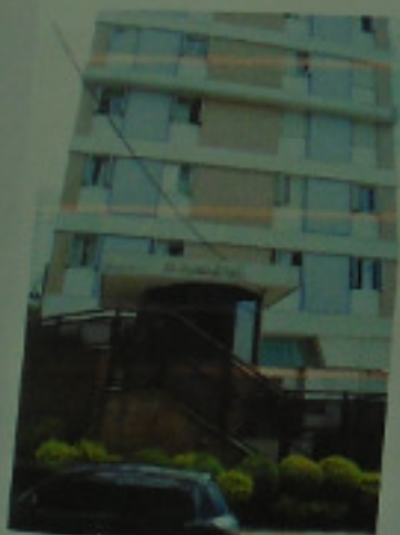
Foto 01 - Fachada do Prédio
