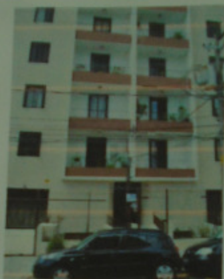
Foto 04 - Prédio de frente ao IA
